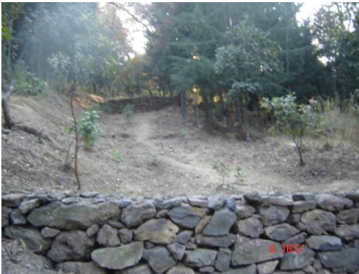
Obras de conservación Santa Cecilia Tepetlapa
