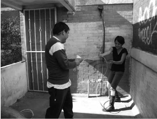
Pelado de cables
