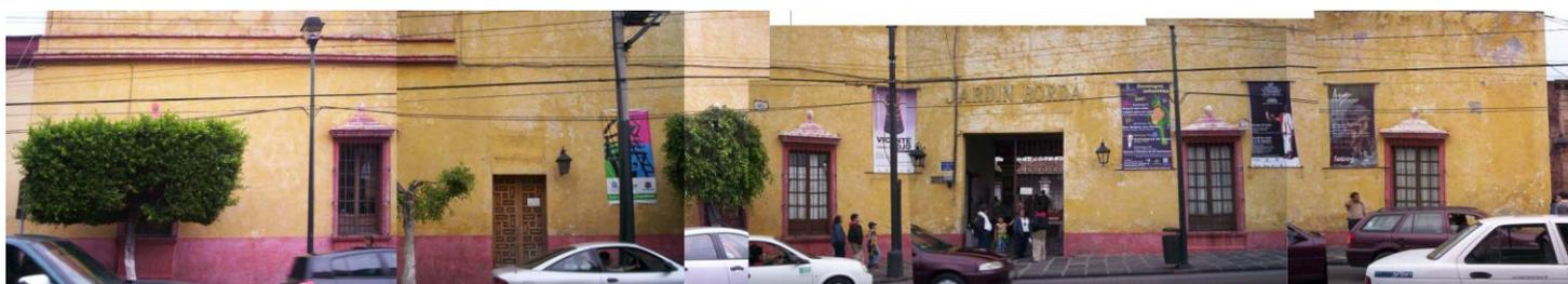
**Imagen No.45.** Estado actual de la fachada principal del conjunto denominado Jardín Borda. Entre los principales deterioros que presenta se observa el desprendimiento del aplanado por falta de mantenimiento, la presencia de manchas por humedad ascendente, el despostillamiento de las tapas de los repisones, la corrosión y oxidación por humedad e intemperismo en las herrerías y la putrefacción y deformación por humedad en la carpintería de las ventanas. Fuente: A. Cruz. Marzo 2009.
