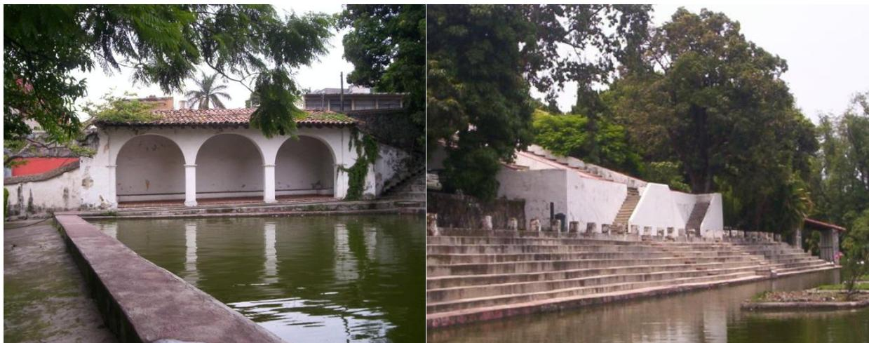
**Imagen No. 109-110.** Estado actual del estanque grande. En la primera imagen se observa el cobertizo situado del norte del mismo; en la segunda imagen se observan las graderías que fueron construidas durante la intervención de 1987, con lo cual se alteró el concepto original que se tenía en el lugar. Fuente: A. Cruz. Julio 2007.
