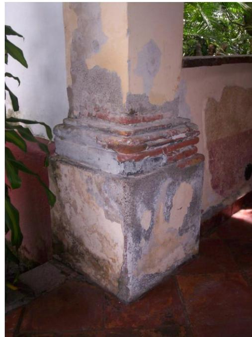
**Imagen No.50, 51.** Detalle de las fábricas en las portadas internas de las estancias ubicadas a cada lado del ingreso secundario de la Casa Borda, se observa el despostillamiento y desgaste en las piezas de azulejo de la portada; Abajo. Detalle de fábrica de los pilares del patio No.3: tabiques de arcilla roja, se observa el deterioro por desprendimiento de aplanado en base de los pilares por falta de mantenimiento e intemperismo. Fuente: A. Cruz. Mayo 2011.
