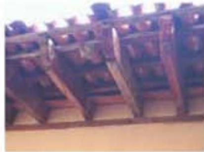
FOTO 003. Detalle del sistema de cubierta de tipo de vigas de madera.
