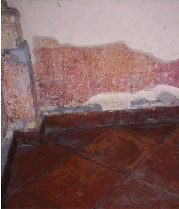
**Imagen No.49.** Detalle de guardapolvo en muros de la casa ubicados en el patio No.3, se observa el desprendimiento de aplanado y pintura por falta de mantenimiento, así como la presencia de manchas de humedad ascendente. Fuente: A. Cruz. Mayo 2011.
