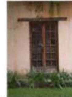
FOTO No. 6. Detalle de desprendimiento de acabado final en puerta de madera por intemperismo. Detalle de desprendimiento de esplanado y pintura.
