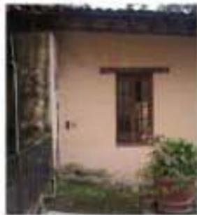
FOTO 002. Detalle del vano de una ventana, con el marco de madera y el muro de fábrica.
