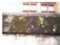
FOTO 007. Estado de deterioro de muros debido a humedad excesiva en zona de plaza por deterioro excesivo e infiltración.
