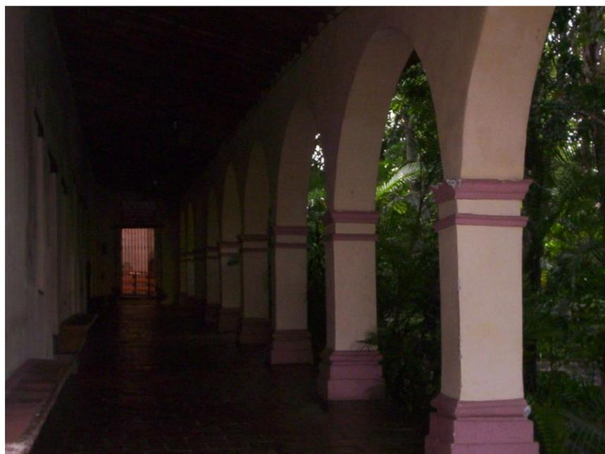
**Imagen No.100.** Fachada sur del Segundo volumen, hoy Museo de Sitio del Centro cultural Jardín Borda. Se observa que presenta deterioros considerables como desprendimientos de aplanados y pintura por humedad ascendente en sus muros, la pérdida del entablado de madera en la techumbre, la concentración de flora parasita, entre otros. **Fuente:** A. Cruz. Julio 2007.
