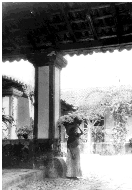
**Imagen No.34.** Ingreso al patio No.2 o -patio de las carrozas-, ca. 1930. En la imagen se observa el cambio de nivel existente entre el ingreso del 2do. zaguán hacia el patio con respecto a los corredores; así como el detalle de unos de los pilares que sostiene la cubierta, y las guarda carretas que delimitan el ingreso al patio. Fuente: FCNMH/ 688-4.
