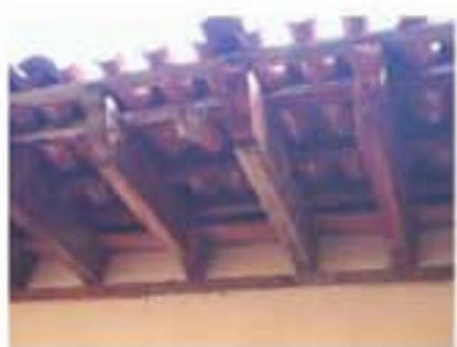
FOTO 002. Detalle del sistema de cubierta de vigas de madera y teja.
