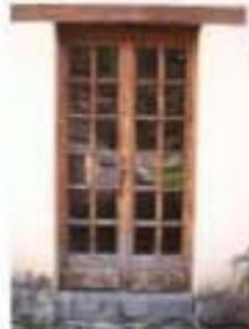
FOTO No. 9. Detalle de desprendimiento de acabado final en puerta de madera por intemperismo. Desprendimiento de esplanado y pintura suelta debido a la humedad.
