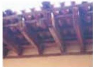
FOTO No. 3. Detalle del deterioro en sistema de cubierta. Se observa la pérdida del embudo de madera y el desprendimiento de tejas sobre la misma.
