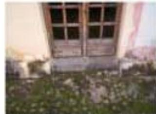
FOTO No. 4. Presencia de manchas de humedad debido a humedad ascendente. Desprendimiento de esplanado y pintura suelta debido a la humedad.
