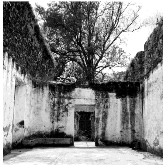
**Imagen No.97.** Estado de deterioro en el que se encontraba el 2do. Volumen del Jardín Borda antes de su restauración en 1992. Se observa entre sus deterioros la pérdida de sus techumbres que provocó problemas de escurrimientos en muros, asimismo se observa en esta imagen problemas de humedad ascendente. Imagen Fuente: FCNMH/0843-008.
