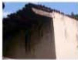
FOTO 002. 1. Estado de deterioro en esquina de muros. 2. Se observa pérdida del acabado de muros y el deterioro de los muros.
