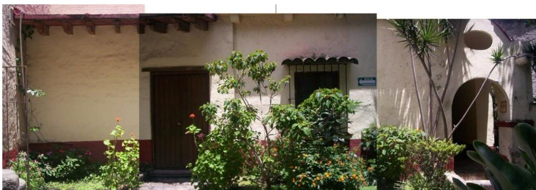
**Imagen No. 95.** Fachada poniente del área de servicio del Centro Cultural. Se observa que sobre esta fachada fueron construidas guarniciones que albergan arbustos menores elegidos sin ningún criterio, se presenta un deterioro en los muros existiendo desprendimientos de aplanados por escurrimientos pluviales. **Fuente:** A. Cruz. Septiembre 2007.
