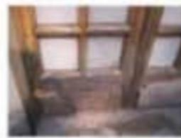
FOTO 008. 1. Estado de deterioro de sistema constructivo, muros y sistema de drenaje debido a humedad excesiva. 2. Presencia de manchas de humedad debido a la humedad excesiva. 3. Presencia de alteraciones en las juntas y la humedad excesiva.
