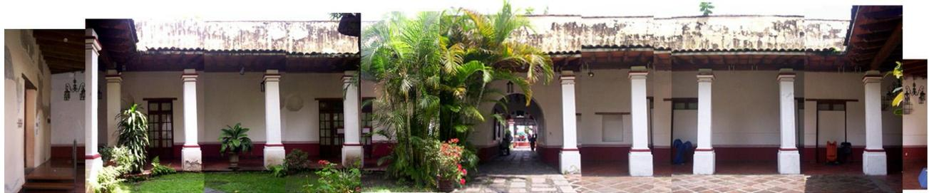
**Imagen No.88.** Estado actual de la fachada poniente del patio No.3. En esta fachada se observa como deterioro, el desprendimiento de aplanados en la base de las columnas, la concentración microflora y flora en la cubierta y pretiles, la clausura de óculos originales. Fuente: A. Cruz. Marzo 2009.
