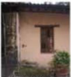
FOTO No. 7. Detalle de desprendimiento de acabado final en ventana de madera. Tipo I.
