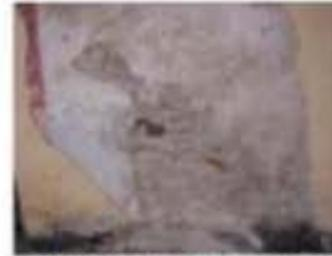
FOTO No. 10. Presencia de manchas de humedad debido a humedad ascendente. Desprendimiento de esplanado y pintura suelta debido a la humedad.
