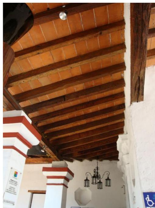
**Imagen No.52.** Sistema Constructivo: Detalle de cubierta en corredores: vigería de madera apoyada sobre columnas de tabique. Fuente: A. Cruz. Marzo 2009.
