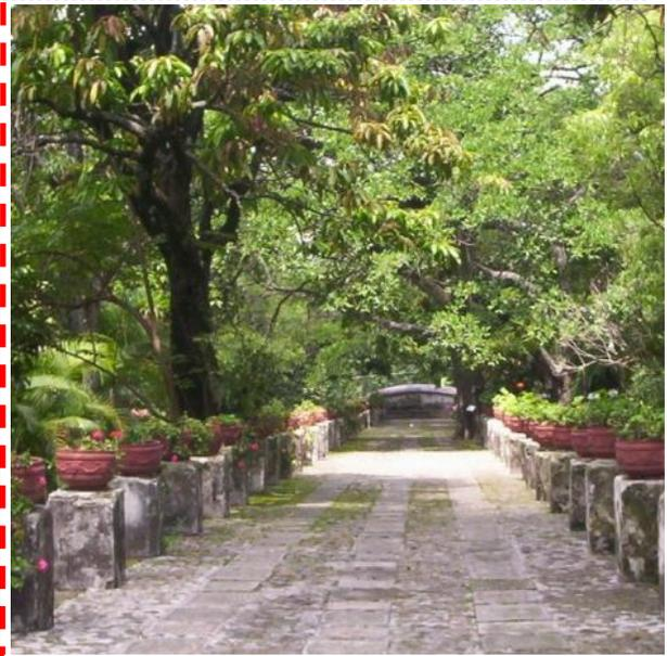
**Imagen No.6 I B.** Estado actual de la Rampa de los Dados mirando al oriente. En la imagen se observa el estado de conservación de esta zona, existiendo algunas modificaciones con respecto a la imagen anterior, entre ellas se aprecia la reconstrucción de los andadores, el desprendimiento de aplanados y presencia de manchas de humedad en los postes y el faltante de los florones originales sobre los mismos. Fuente: A. Cruz. Julio 2007.
