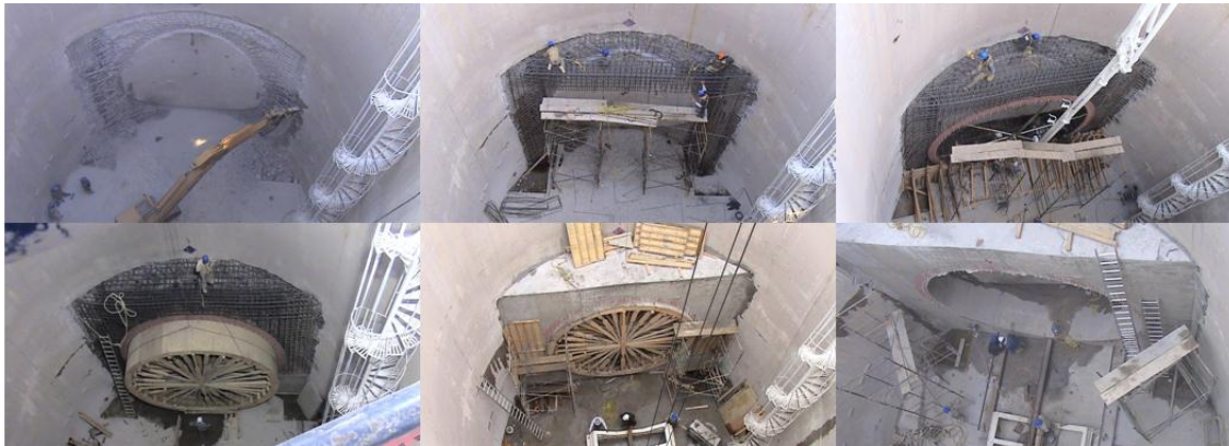
FIGURA 5.3 CONSTRUCCIÓN DEL PORTAL DE ENTRADA DEL ESCUDO
