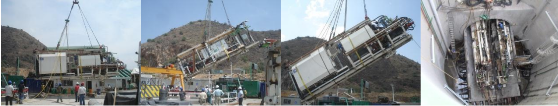
FIGURA 5.8 MANIOBRA DE BAJADA DEL CARRO DOS DE LA TUNELADORA
