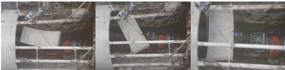
FIGURA 5.4 BAJADA DE DOVELAS AL INTERIOR DEL TÚNEL
