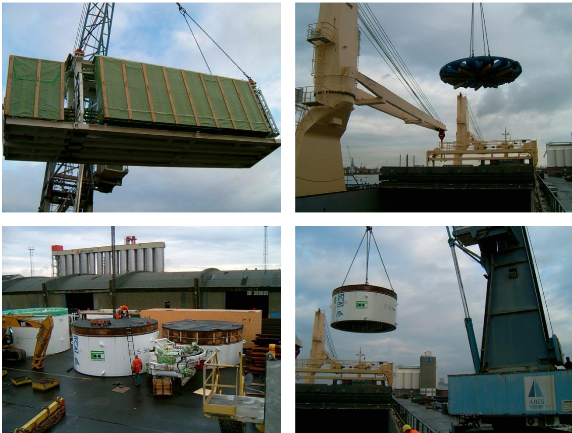
FIGURA 5.1 IMÁGENES DE CARGA Y DESCARGA DE LA TUNELADORA
