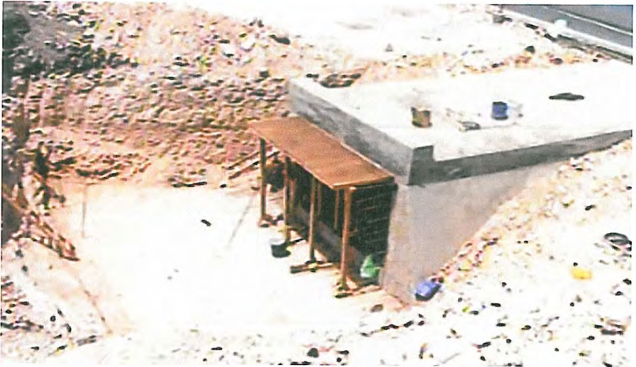
PASO GANADERO KM 10+340
