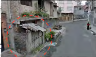
CONSTRUCCIÓN INVADIENDO LA BANQUETA
