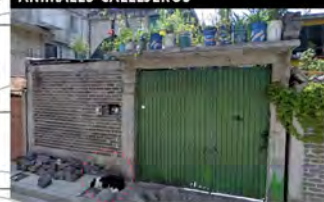
CASCAJO Y ESCALONES EN LA BANQUETA
