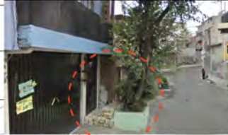
OBSTRUCCION POR AUTOCONSTRUCCION
