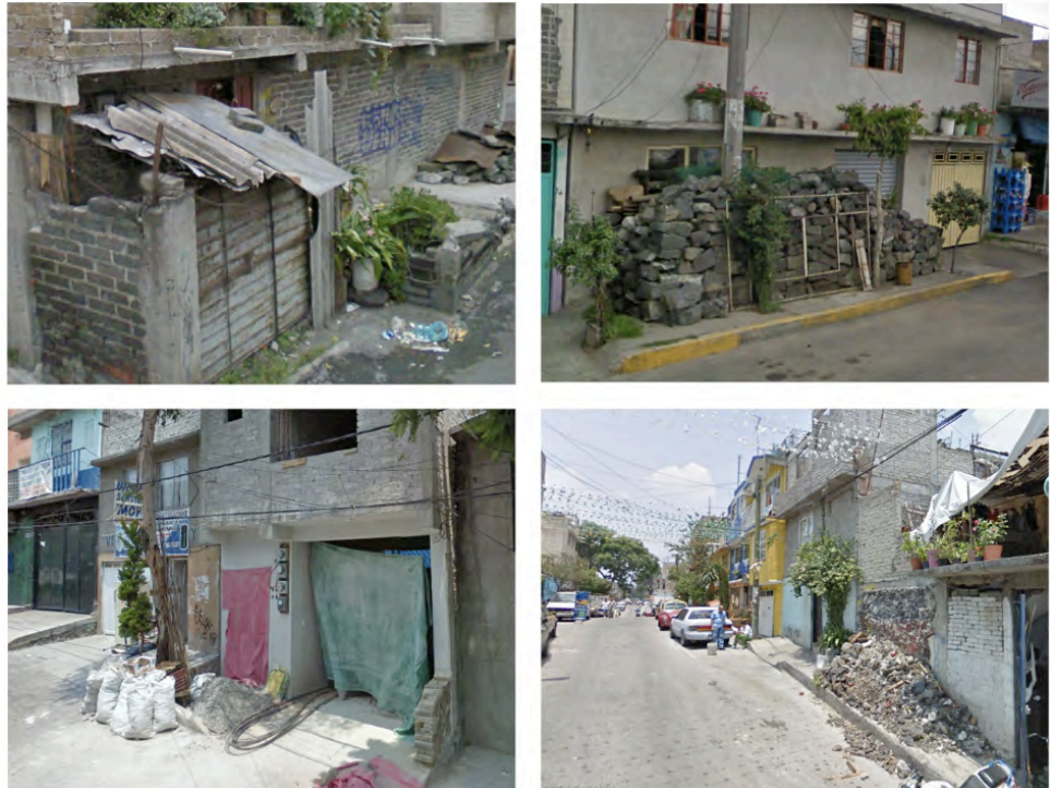
Cascajo y material de construcción obstruyendo calles y banquetas.
