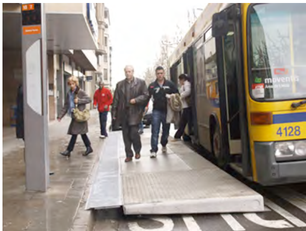
Acera modular para la formación de paradas de autobuses, sin obra civil, que tiene la capacidad de nivelarse para conseguir una prolongación a cota de la banqueta de obra civil y así facilitar el acceso al autobús a todos los usuarios. Fuente: GITMA Mobiliario Urbano.
