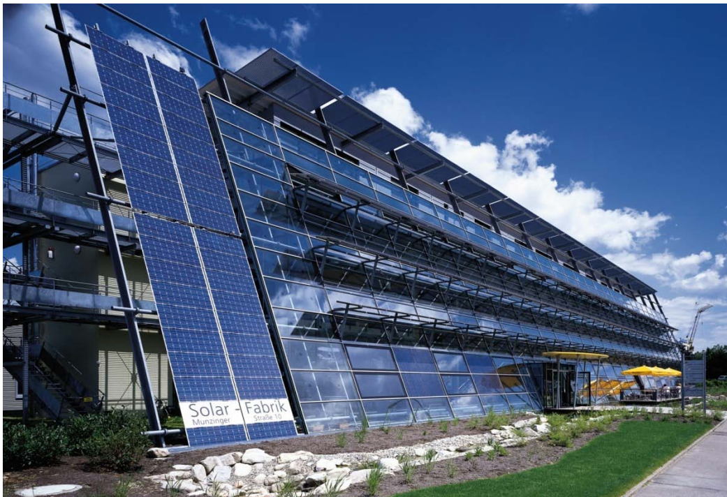
Ilustración 95: La primera fábrica semi-automatizada de celdas fotovoltaicas, la “Solar-Fabrik” en Friburgo, Alemania, está diseñada para climatización natural, aprovechando ductos enterrados, espejos de agua etc., foto: A.Schumann 1998
