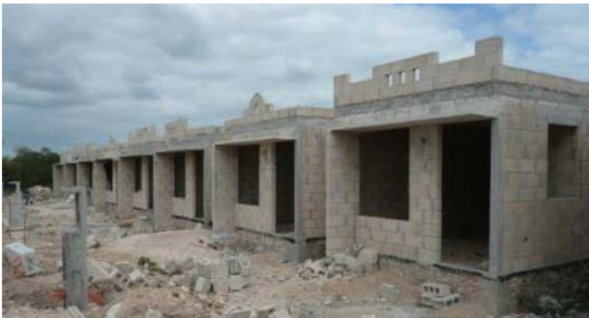
Ilustración 25: Casas en obra negra, Candel, Mérida foto: A. Schumann 2010
