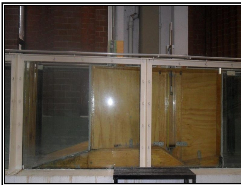
Figura 101. Colocación del desviador a 0.75 m antes del Parshall, vista de perfil.
