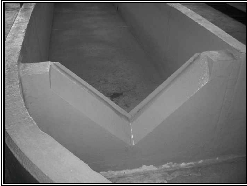
Figura 12. Vertedor triangular.
