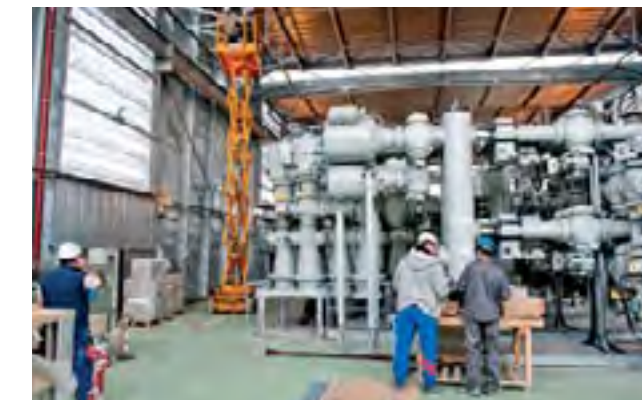
Imagen 50: Trabajadores en la nueva subestación de Seine. / RTE. www.revistaentrelneas.es
