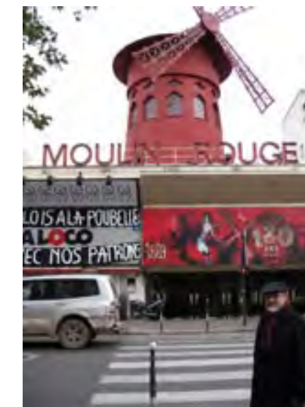
Imagen 101: Fachada del estado actual del Moulin Rouge, por Arq. Héctor García Escorza.
