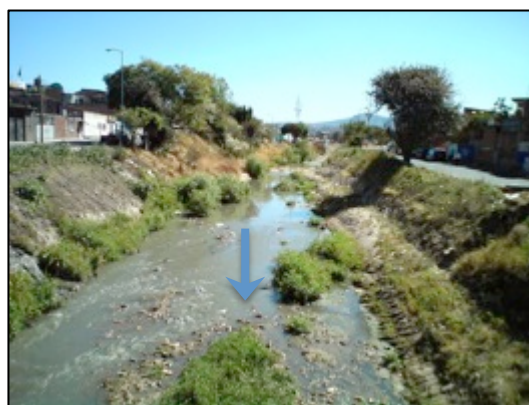
Figura 56. Corriente principal (perenne) Av. Michoacán . Se observa la corriente superficial durante la temporada de secas (cuarta campaña de muestreo). La flecha indica el sentido del flujo de agua. Nota: la imagen fue tomada desde un puente peatonal.
