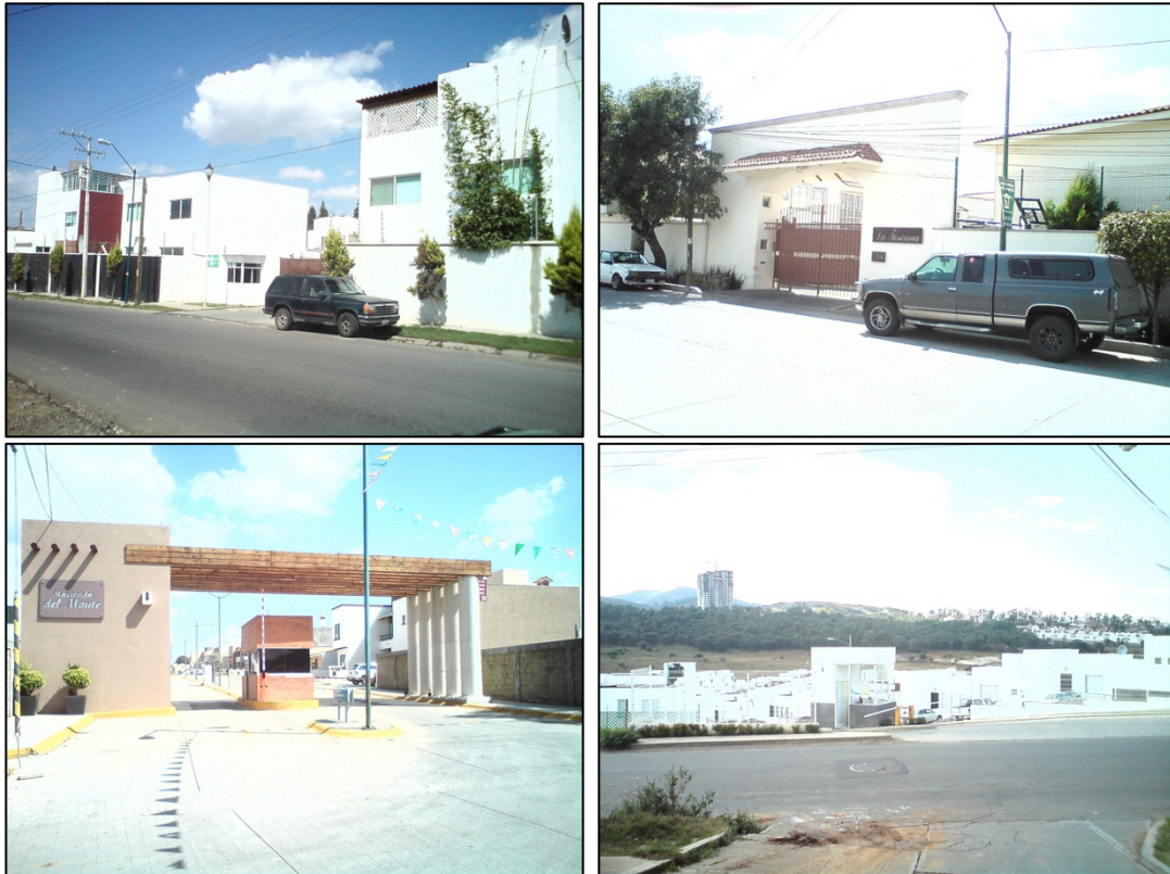
Figura 80. Fraccionamientos privados de reciente construcción en la localidad de JM. En las dos imágenes de arriba y la de abajo a la izquierda se observan algunos de los fraccionamientos privados ubicados en la avenida principal de JM. Abajo a la derecha se ve otro situado al sur de la localidad (en la carretera que la rodea y que va hacia SMM o SJT) el cual es parte del CHC Altozano .
