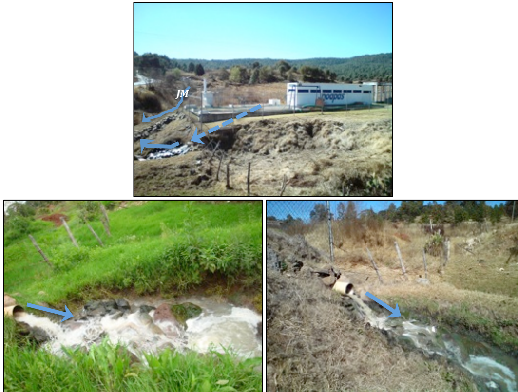
Figura 38. Planta de tratamiento JM.
