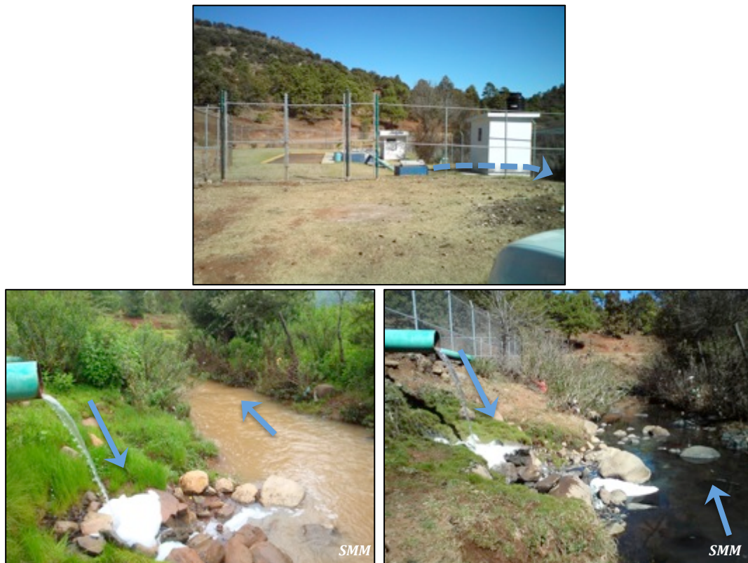
Figura 33. Planta de tratamiento SMM.
