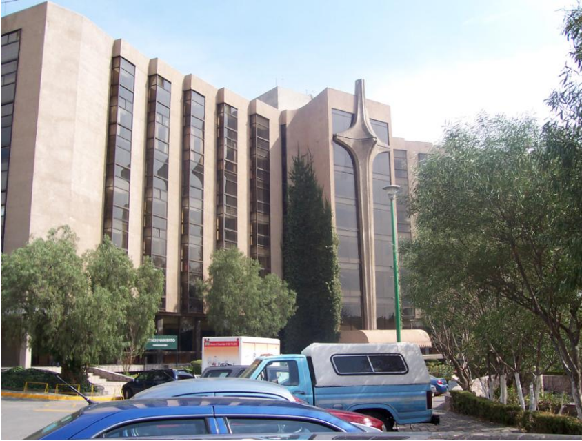
EDIFICIO DE VELATORIOS EN EL PANTEÓN JARDINES DEL RECUERDO, TLANEPANTLA, ESTADO DE MÉXICO.
