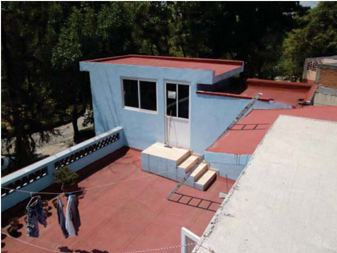
Vista de azotea (ampliación para dormitorios)
