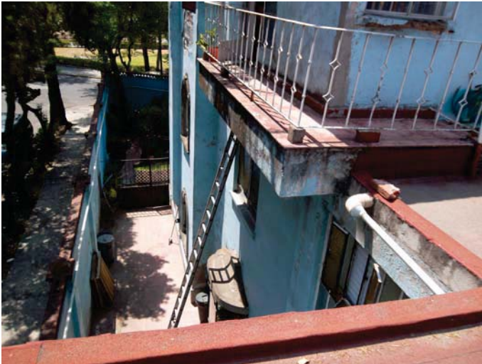
Vista de patio lateral
