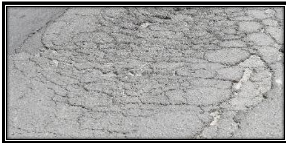
Fig. 2.12 Agrietamiento parabólico
