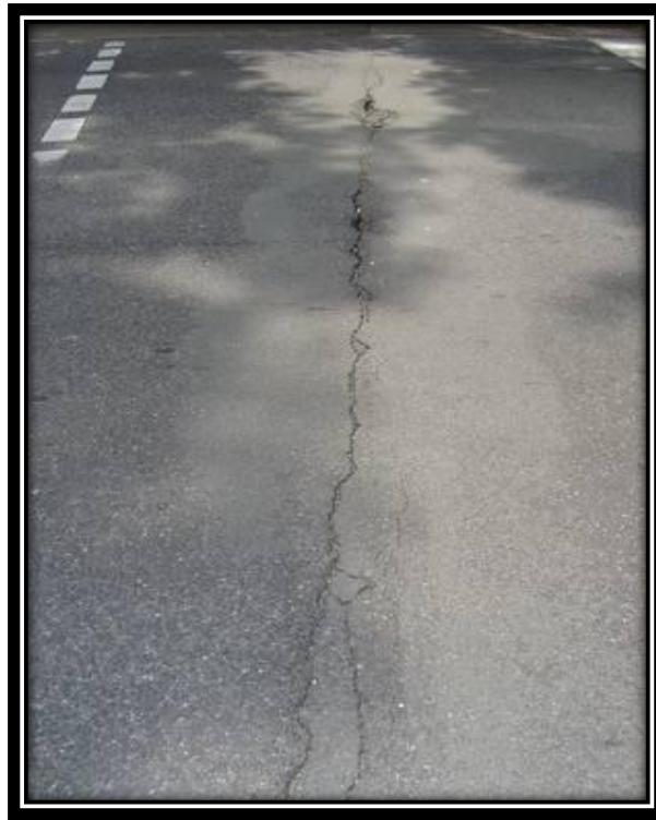
Fig. 2.18 Agrietamiento longitudinal
