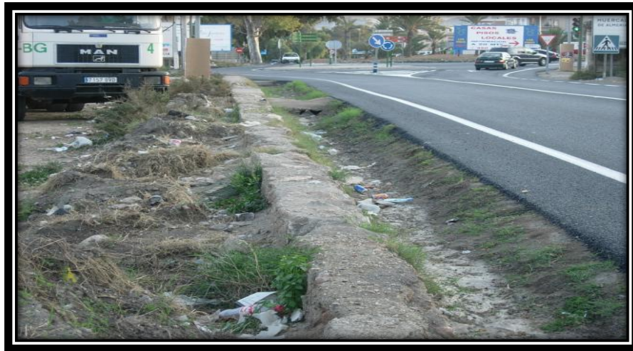
Fig. 2.21 Crecimiento de hierba entre carpeta y cuneta
