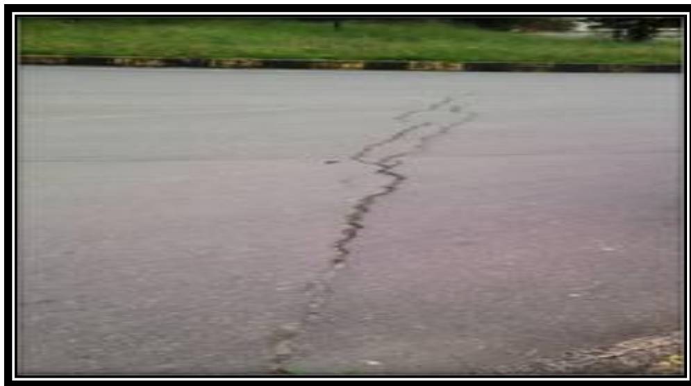
Fig. 2.17 Grieta transversal
