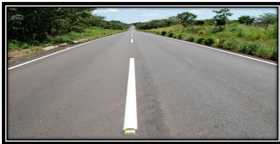
Fig. 2.7 Roderas o canalizaciones
