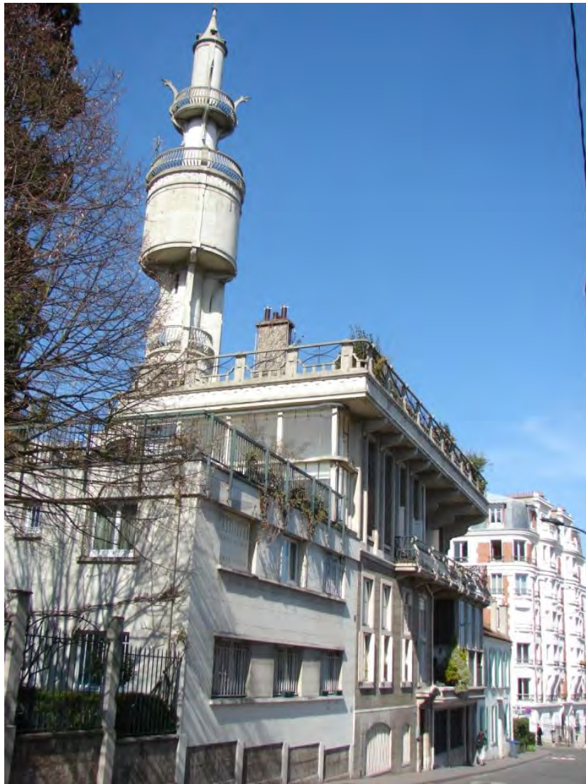
Fig. 39. Construcción de casa en Bruselas realizada con el sistema Hennebique (1904).
