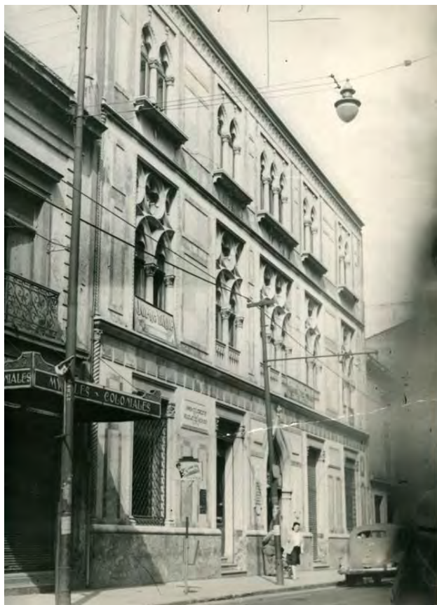
Fig. 117. Bancos Agrícola e Hipotecario hacia 1940, en donde se muestran las modificaciones a dos vanos de las ventanas para alojar a comercios.
