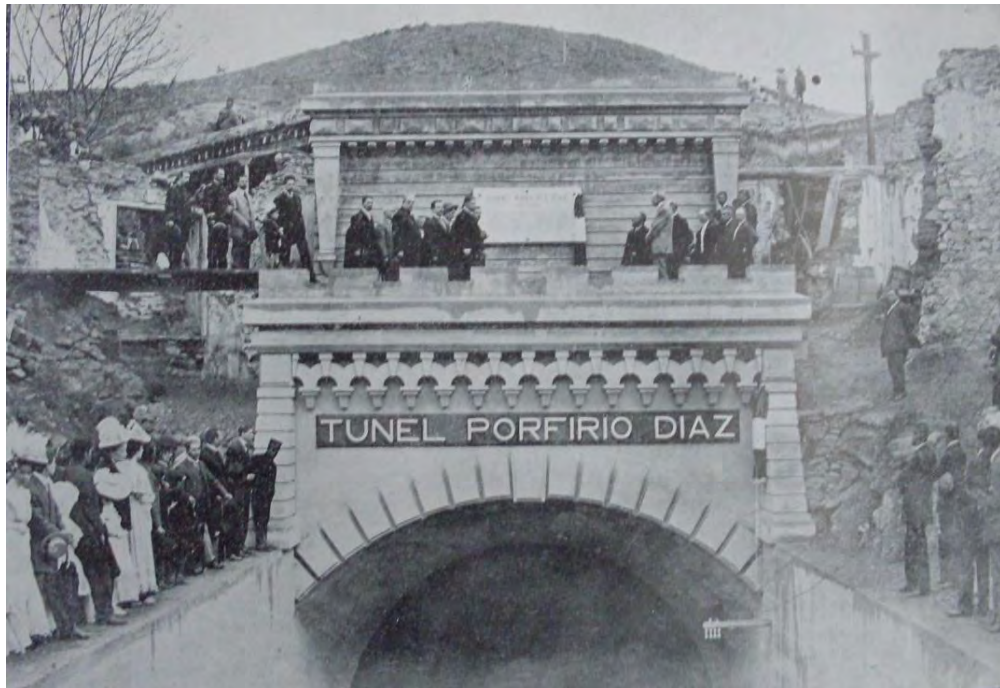
Fig. 32. Túnel del “Gran Canal del Desagüe” en su inauguración (1910).
