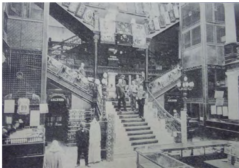
Fig. 107. Elevadores del centro comercial “EL Puerto de Veracruz” (1908).
