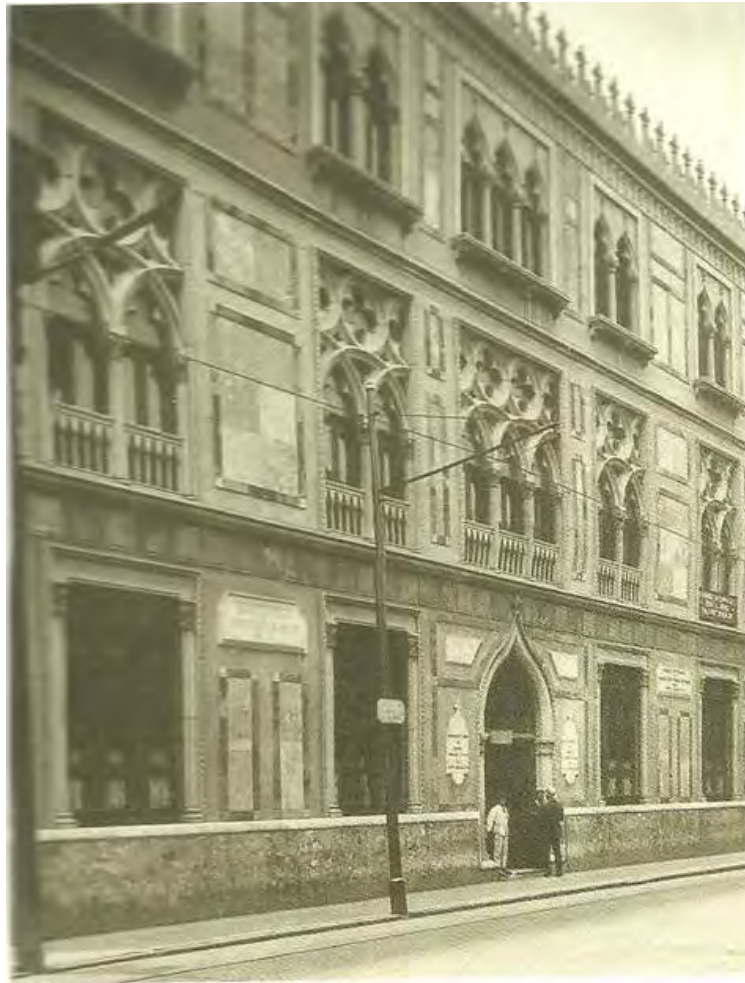
Fig. 46. Edificio del Banco Agrícola e Hipotecario de México (1905).
