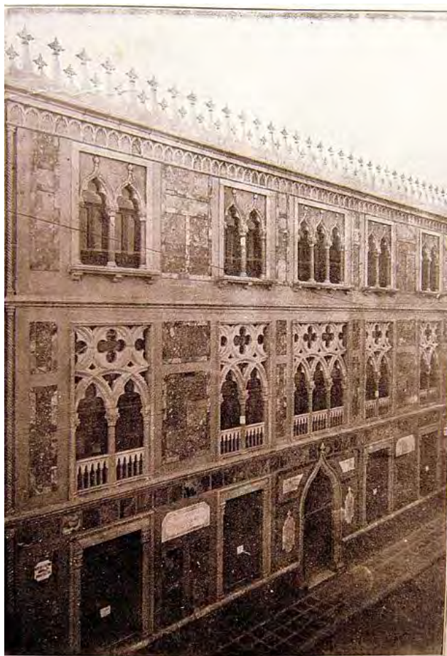
Fig. 100. Fachada de los Bancos Agrícola e Hipotecario de México (1905).
