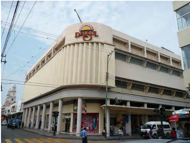
Fig. 44. Mérida. Construcciones de concreto armado realizadas hacia 1903. En día, esta obra presenta múltiples modificaciones.
