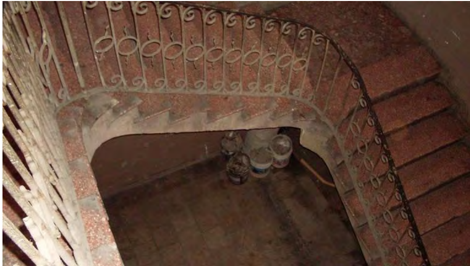
Fig.116. Escalera de hierro laminado y remache con forja. Originalmente tenía un pasamanos de madera.
