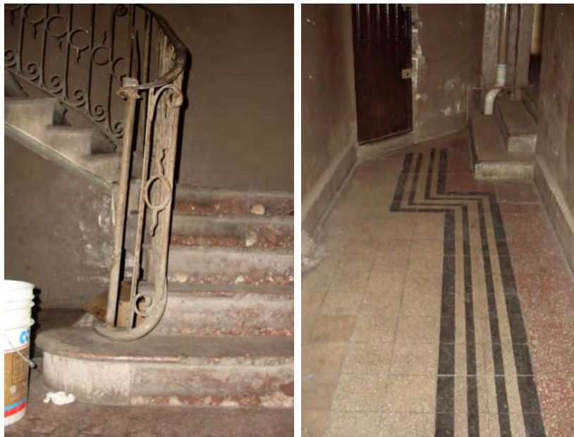
Fig. 111 y Fig. 112. Detalle de las escaleras y del piso de mosaico, planta baja (2010).
