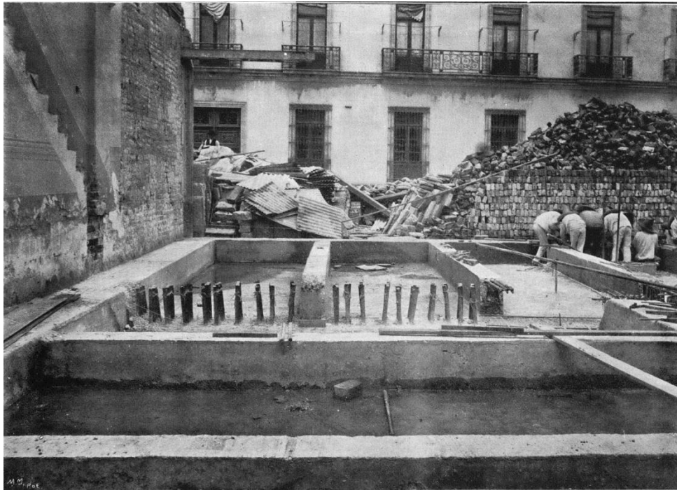
Fig. 49. Cimientos de la Secretaría de Relaciones Exteriores. Terminado de las zapatas.
