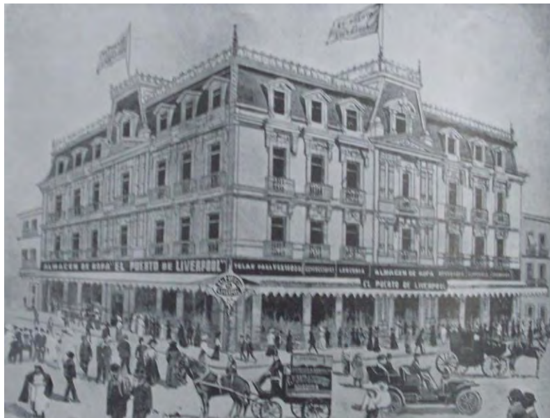
Fig. 35. Almacenes El puerto de Liverpool.
