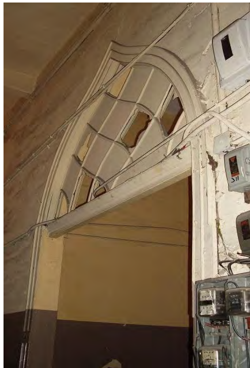
Fig.115. Acceso en forma de arco conopial que conduce al primer patio del inmueble.
