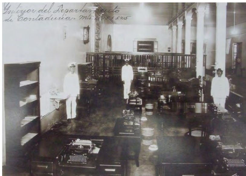
Fig. 87. Sucursal del Banco Nacional de México en Mazatlán. La imagen muestra la sencillez del espacio pero no por ello carece de servicios como energía eléctrica, drenaje y agua corriente.
