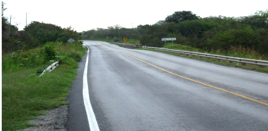
Figura 5.12. Vista general del tramo en estudio del kilómetro 32+440 hacia adelante. Se aprecia el señalamiento en buen estado y ondulaciones del pavimento.
