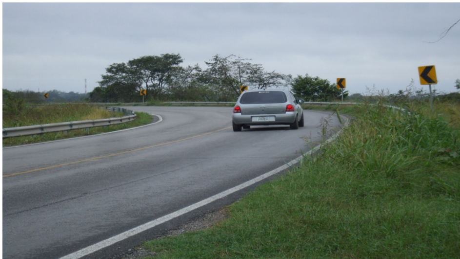
Figura 5.11. Vista general antes de la curva del kilómetro 32+400. Se aprecia señalamiento en buen estado.
