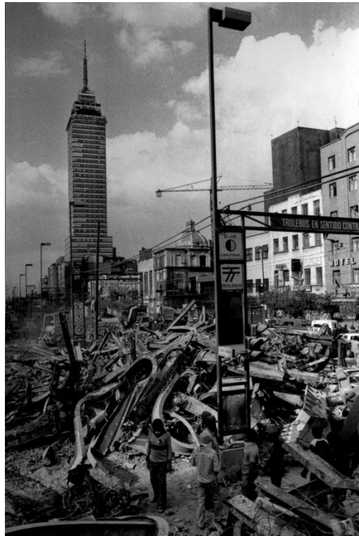
10. Andrés Garay, Escombros del edificio Super Leche, México, D.F. 1985. Publicada en La Jornada , septiembre, 1985. Museo Mirador Torre Latinoamericana.
