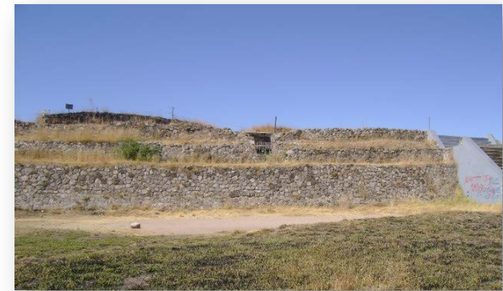
Horizontalidad de la Estructura I. foto: 2011 por la autora.
