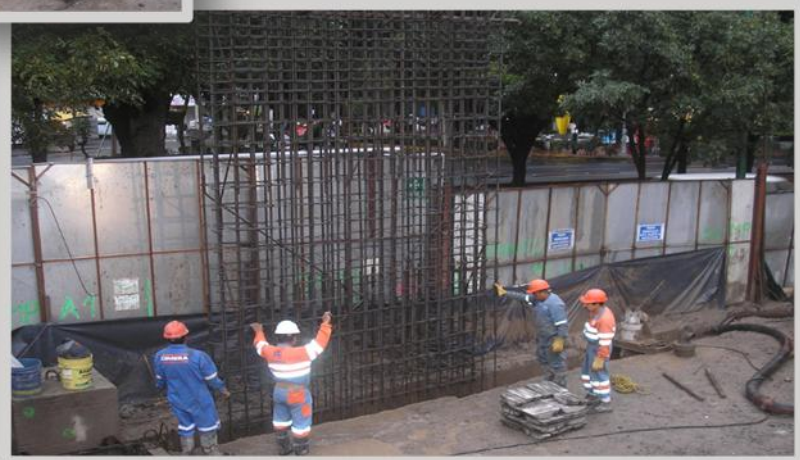
FIGURA NO. 27 Izaje de armado
