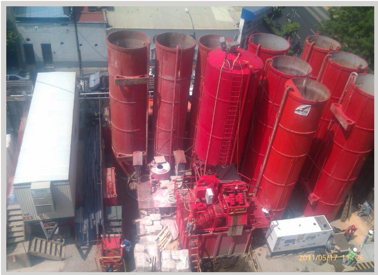
FIGURA NO. 9 Central de Lodo de excavación
