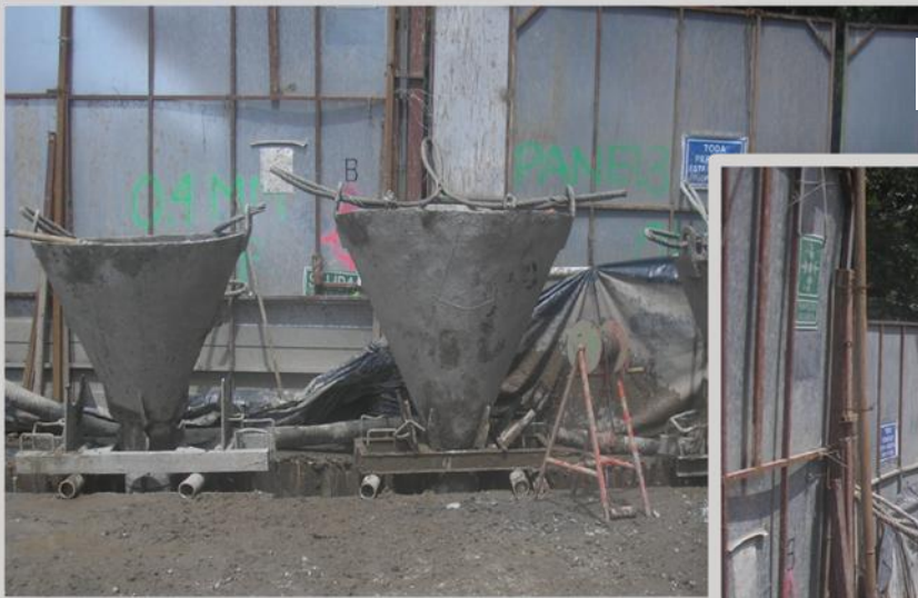
FIGURA NO. 36 Colocación de embudos
