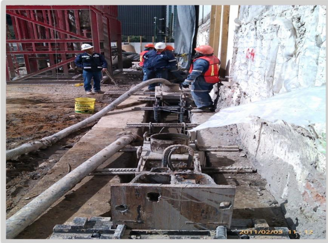
FIGURA NO. 15 Desarenado de muro pantalla
