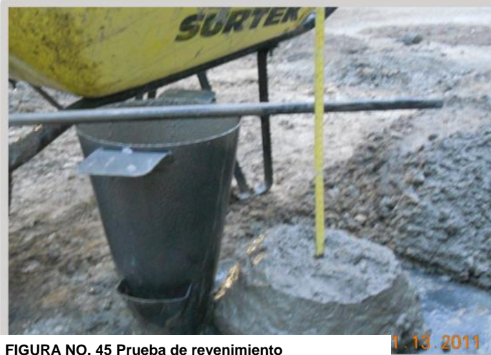
FIGURA NO. 45 Prueba de revenimiento
