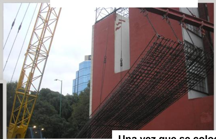
FIGURA NO. 22 Izaje de armado
