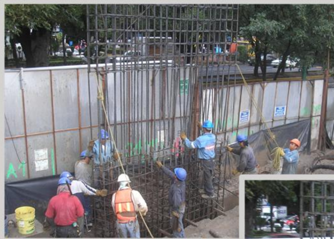
FIGURA NO. 28 Traslape de armado
