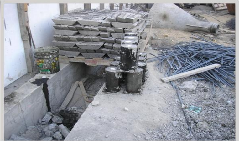
FIGURA NO. 46 Cilindros de concreto
