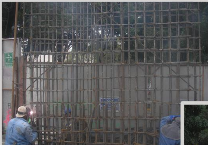
FIGURA NO. 30 Soldadura en traslape de armado.
