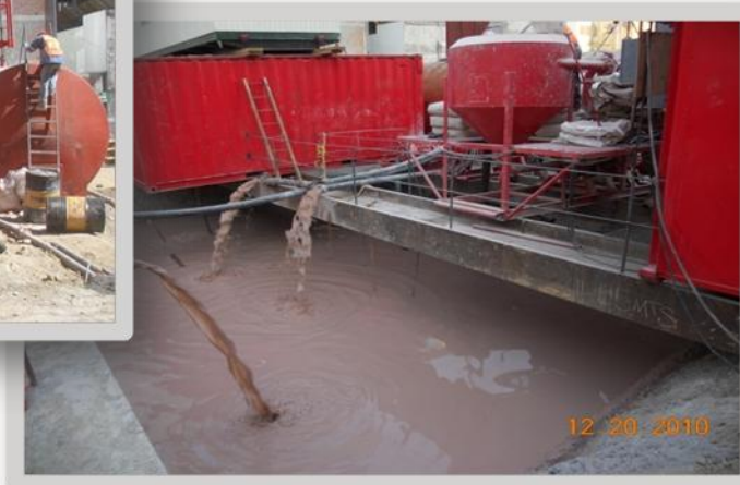
FIGURA NO. 14 Desarenado de muro pantalla
