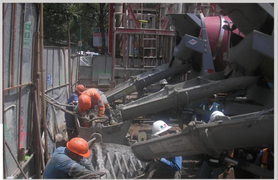
FIGURA NO. 36 Colocación de embudos
