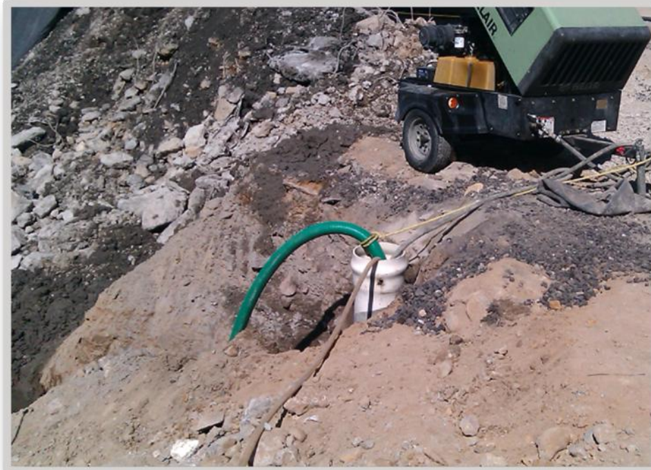
FIGURA NO. 51 Pozo de abatimiento de nivel freático
