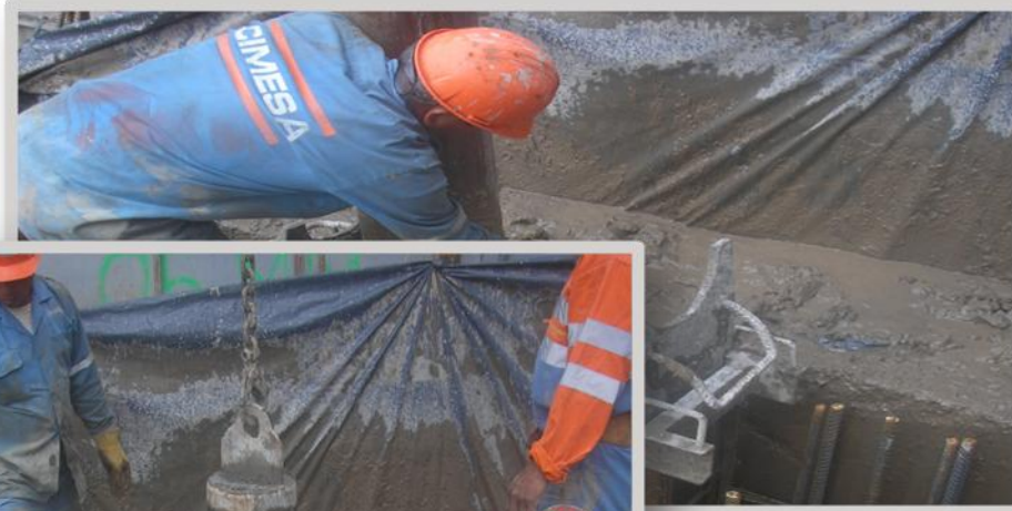
FIGURA NO. 33 Posición final de armado
