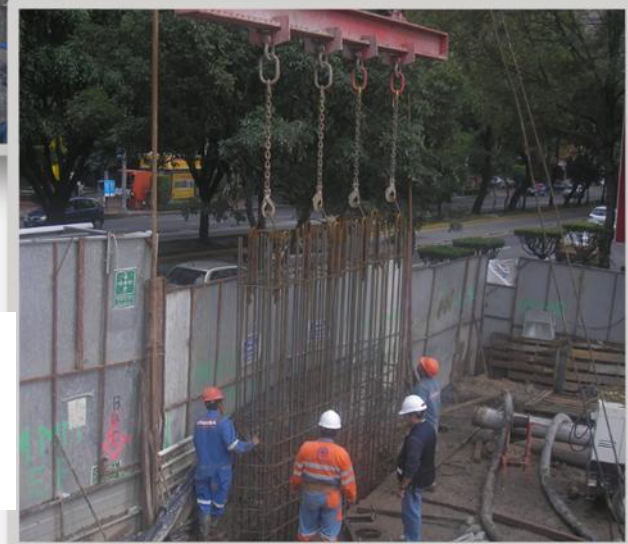
FIGURA NO. 31 Colocación de armado
