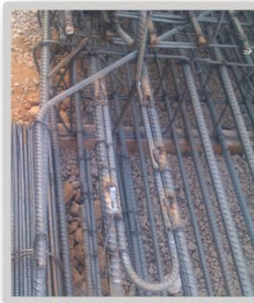
FIGURA NO. 44 Soldadura en asas
