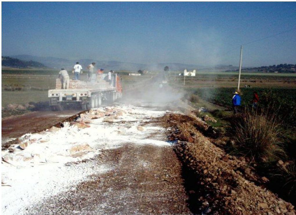
Base estabilizada con cal o cemento Portland.
