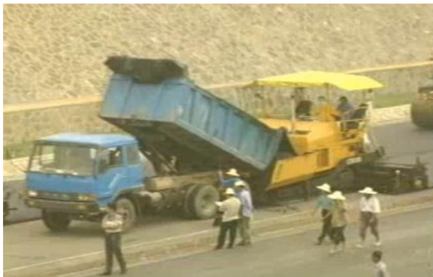
Tendido de carpeta con maquina extendedora Fig. (5.11)
