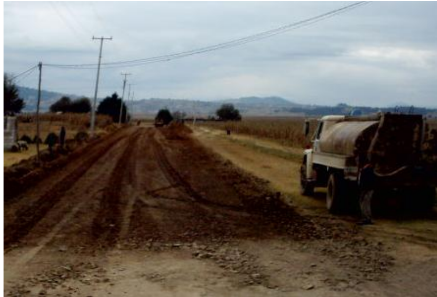
Incorporación de Agua por medio de una Pipa
