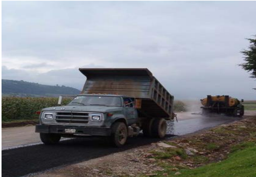
Riego de liga sobre la base impregnada. Fig. (5.10)
