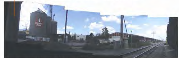
Vista hacia contenedores y bodegas
