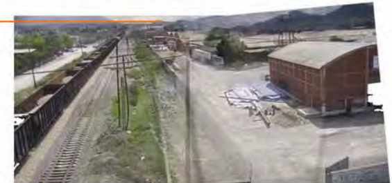
Vista desde periferico hacia bodegas
