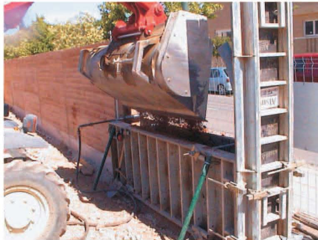
Gráfico: Relleno de mezcla en la cimbra
