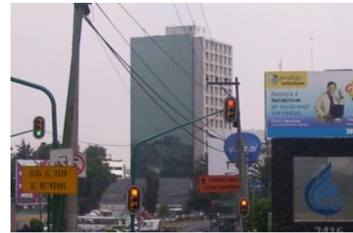
Imagen E: Edificio de la Adjudicatura.
