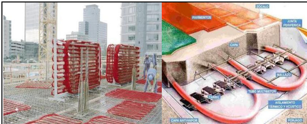
Instalación de forjado radiante.
