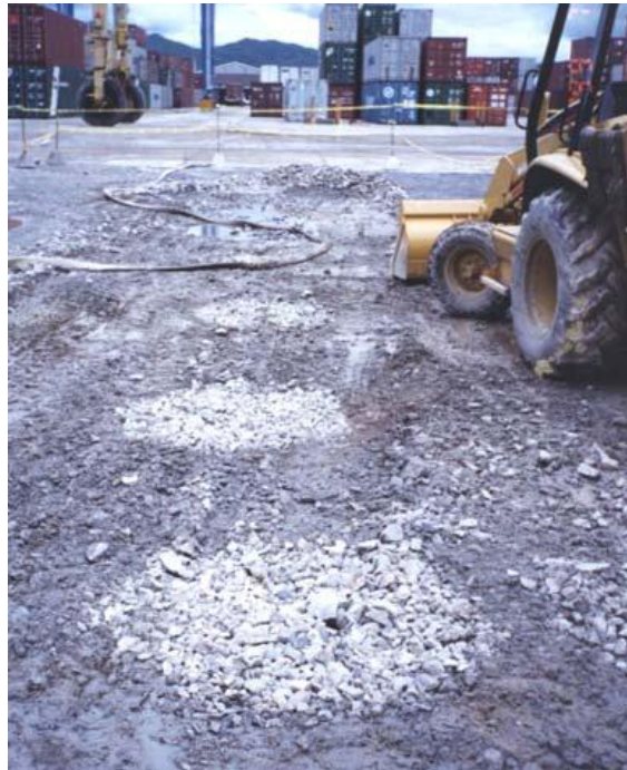
Figura 4.15 Columnas de grava.
