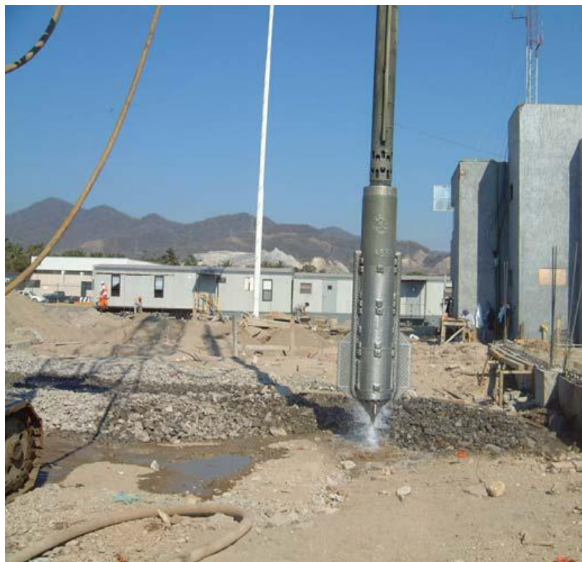
Figura 4.16 Vibrador de fondo tipo "S" en Terminal de Contenedores, Manzanillo, 1998.
