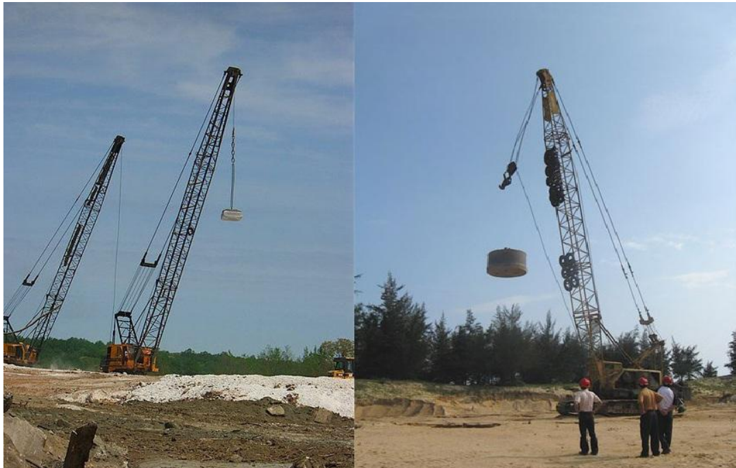
Figura 4.1 Compactación dinámica con una grúa convencional Impacto de la masa causando un cráter.
