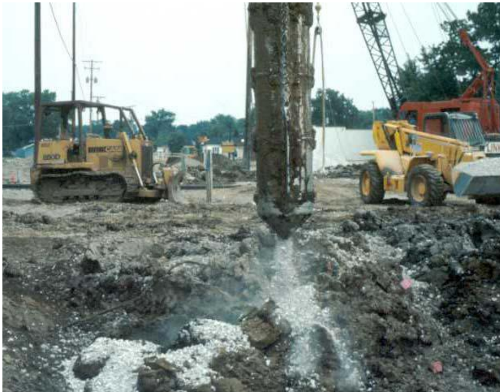
Figura 4.14 Alimentación y salida de grava, con la técnica de vibrodesplazamiento.
