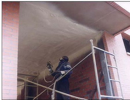
FIGURA 40. Aplicación de la espuma de poliuretano
