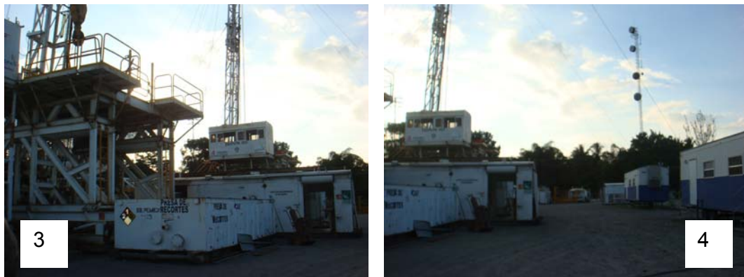
Fotografías del complejo PEMEX ICA tomada el 25 de noviembre del 2009 centro del predio
