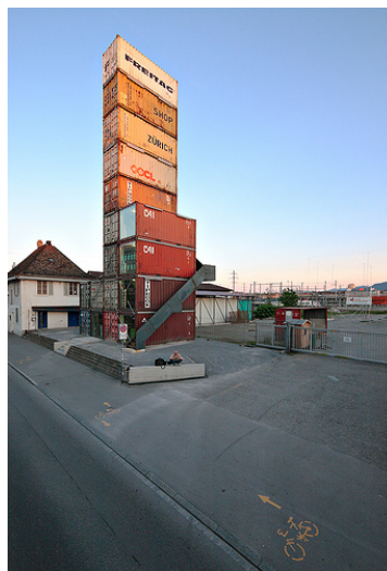
FIGURA 11. Edificio de contenedores
