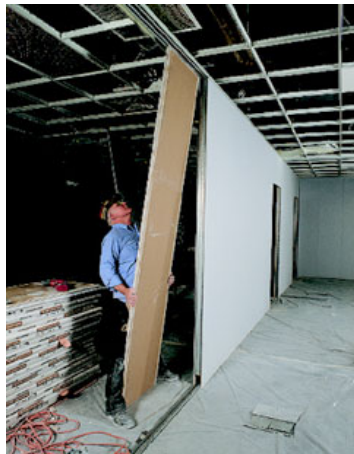
FIGURA 42. Paneles de tabla roca montado vertical
