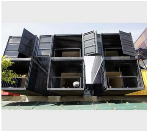
FIGURA 12. Unidad de viviendas contenedor
