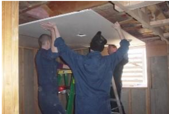
FIGURA 41. Colocación del panel de Tablaroca
