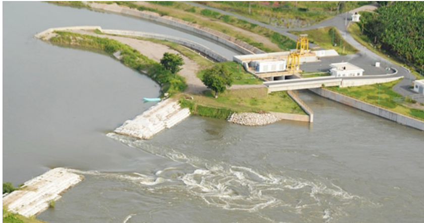
Figura 5.3: Estructura de Control El Macayo
