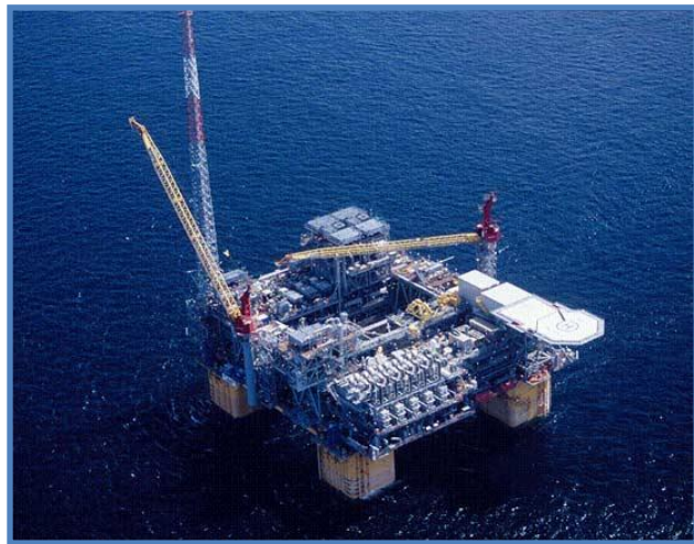
Figura 5- 3 Plataforma semisumergible para el campo Na Kika.
