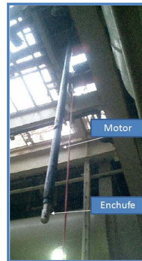
Figura 3- 27 Instalación del BEC por riser.
