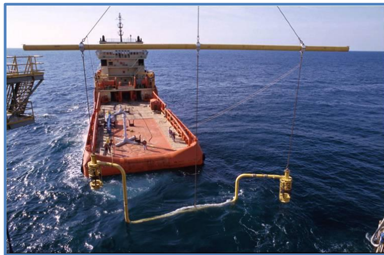
Figura 2- 23 Operaciones para instalar un jumper.
