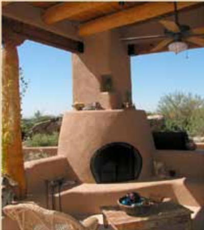
Construcción hecha con Bahareque.
