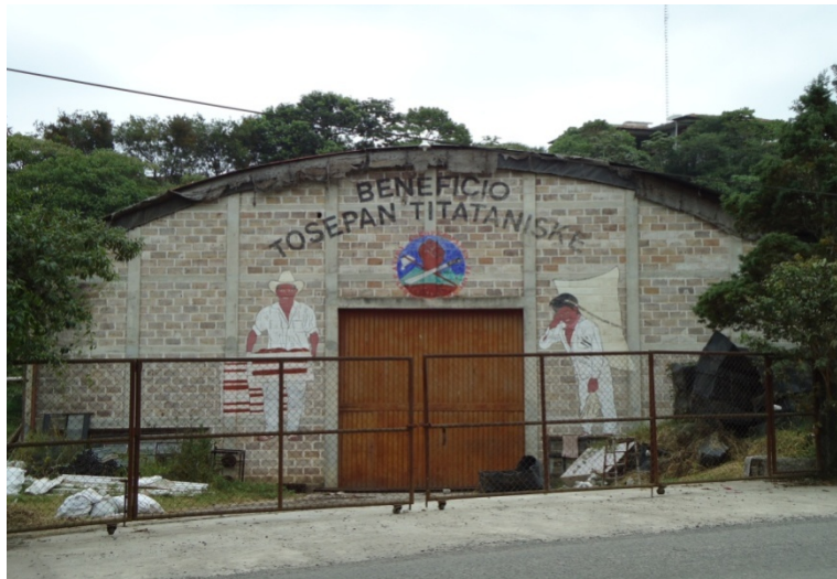
Fachada del beneficio húmedo principal, ubicado a las afueras de Cuetzalan.
