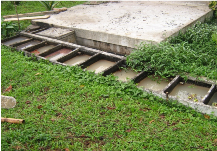
Piletas para la captación de agua de lluvia dispuestas para su reutilización.
