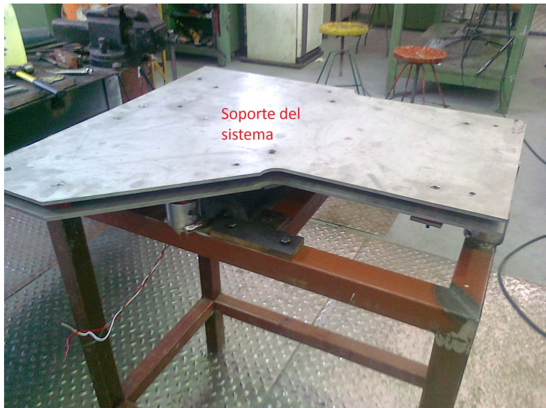
Fig. 5.14. Cuarto paso del ensamble del sistema (montaje del soporte del sistema).
