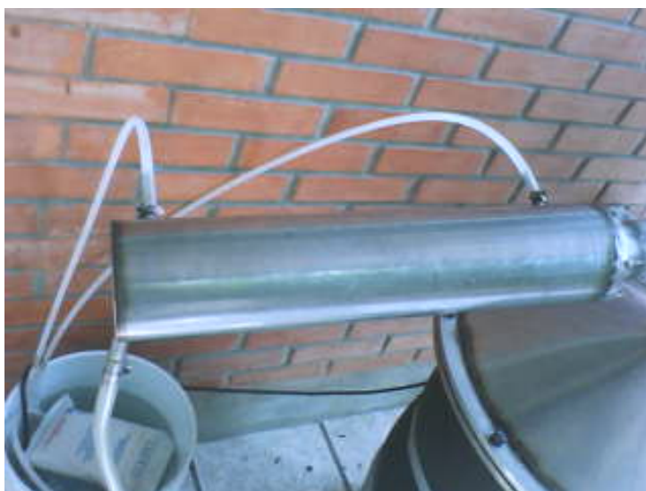
Figura A.6: Condensador acoplado al reactor de destilación.
