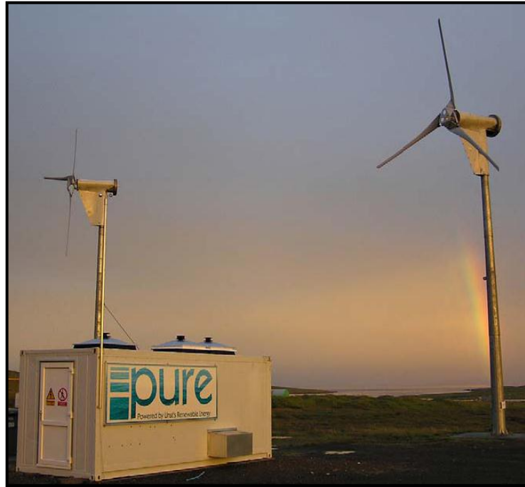
Figura 5. Sistema eólico/hidrógeno instalado en la Isla Unst, Escocia. Tomada de [7].
