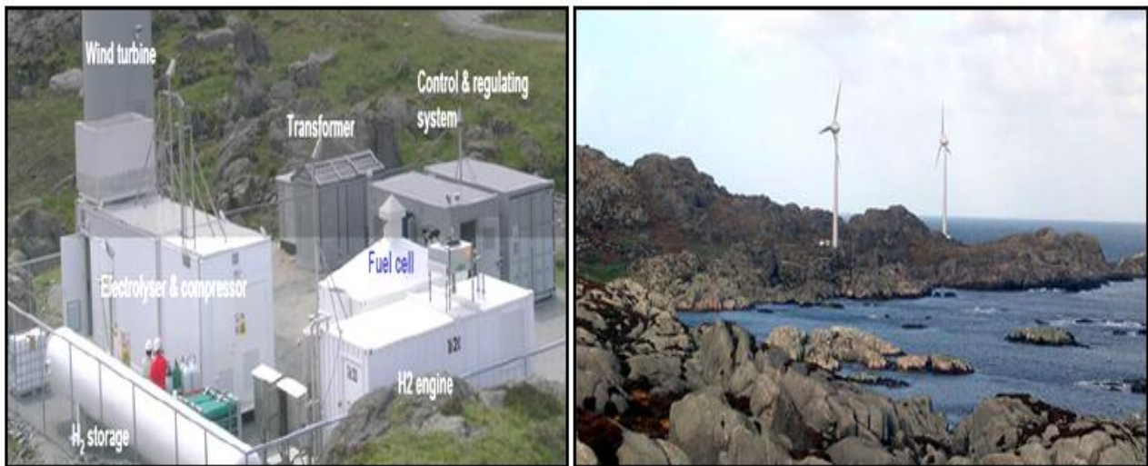
Figura 3. Sistema eólico/hidrógeno instalado en Utsira, Noruega, en julio del 2004. Descargada de: http://www.hydro.com
