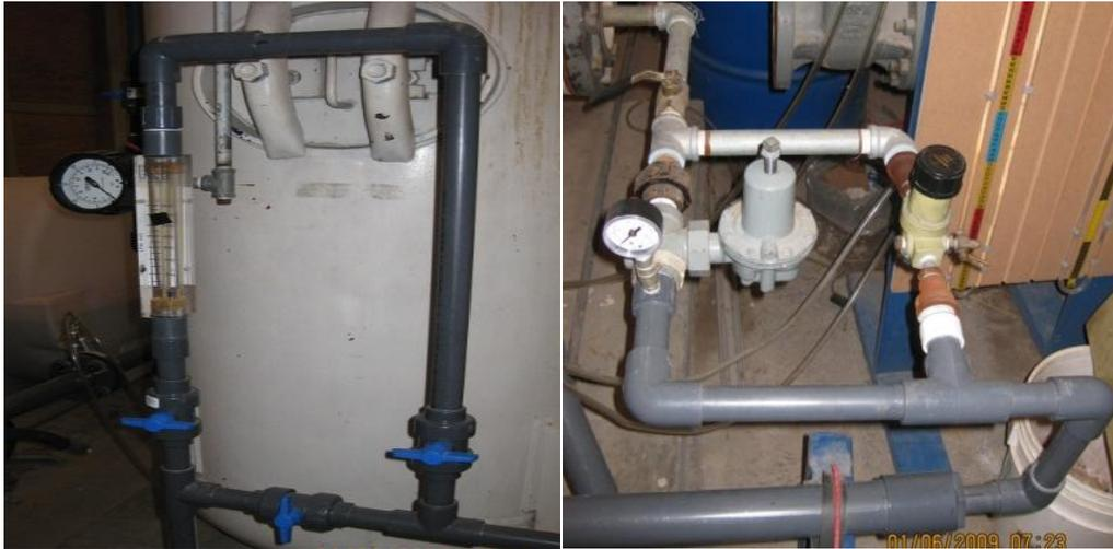
**Fig. 2.6** Manómetro, rotámetro y válvulas reguladoras de presión.
