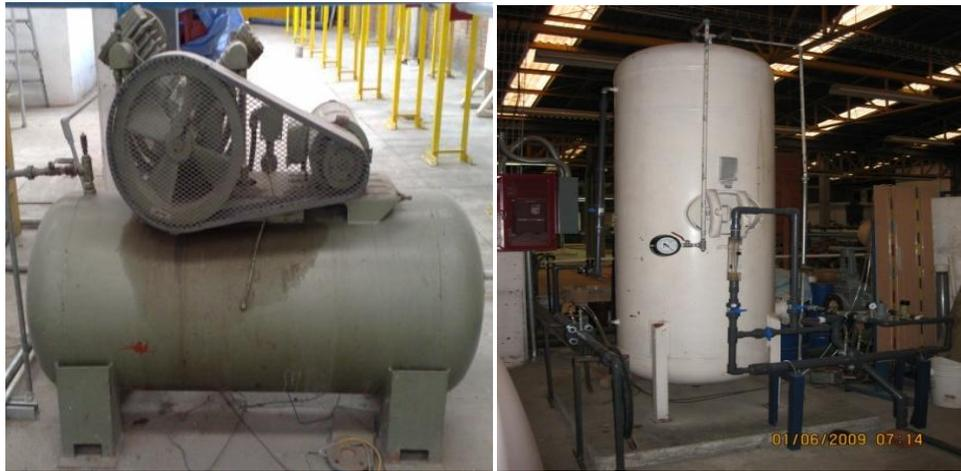
**Fig. 2.5** Compresor (izquierda) y tanque de aire (derecha).
