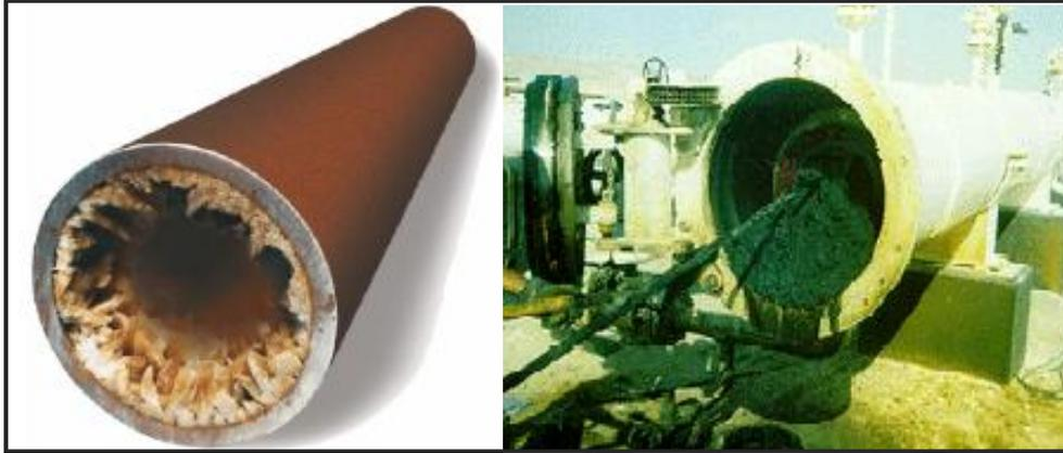
**Fig. 1.1** Incrustación y acumulación de lodos en ductos.
