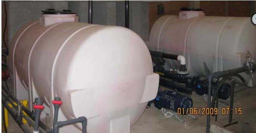
**Fig. 2.2** Tanques de almacenamiento de agua (izquierda) y aceite (derecha).
