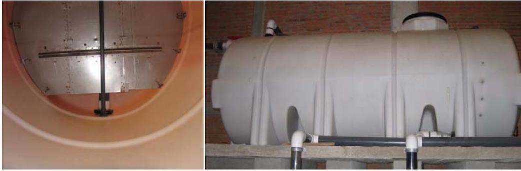
**Fig. 2.7** Separador trifásico y mampara de choque.
