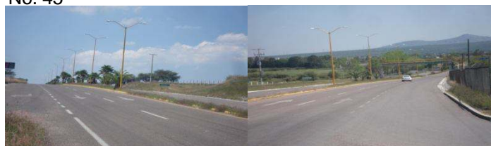
Vista de carretera estatal
