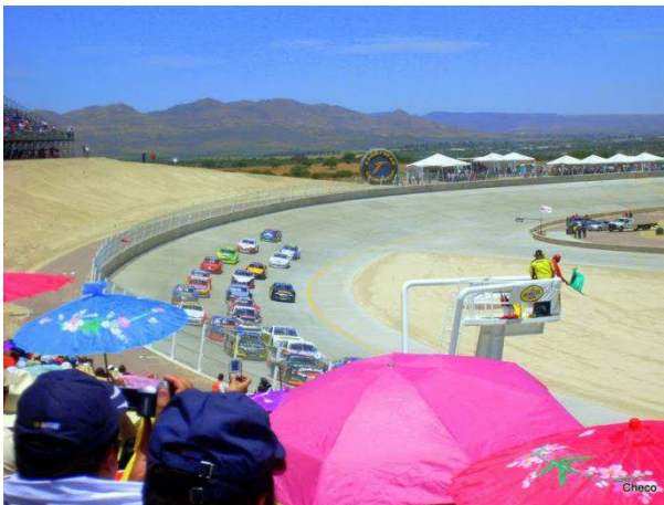
Parte Oeste de la pista
