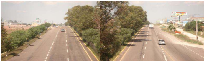
Vista de autopista panamericana No. 45
