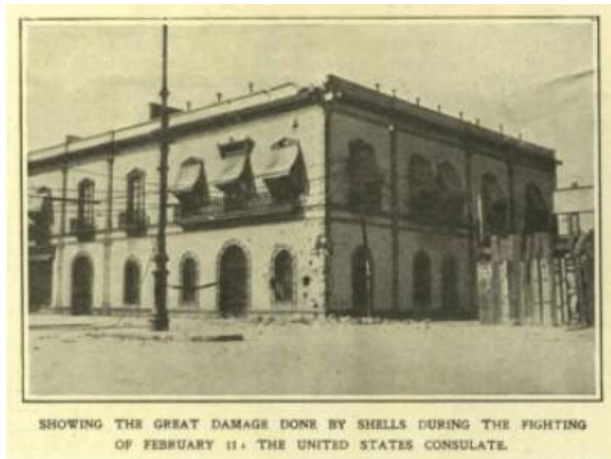
11. Muestra del gran daño hecho por los proyectiles durante los enfrentamientos del 11 de febrero al Consulado de los Estados Unidos
