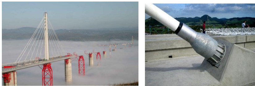
Figura 3.16 Amortiguadores: (a) Puente Millau; (b) Puente del Centenario
