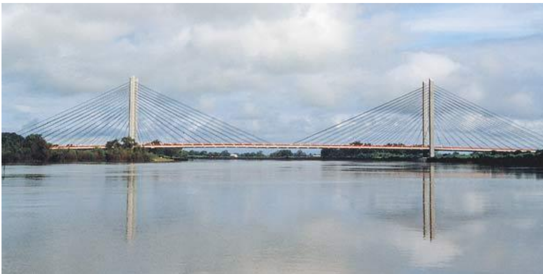
Figura 1.10 Puente río Papaloapan (puente con suspensión lateral)
