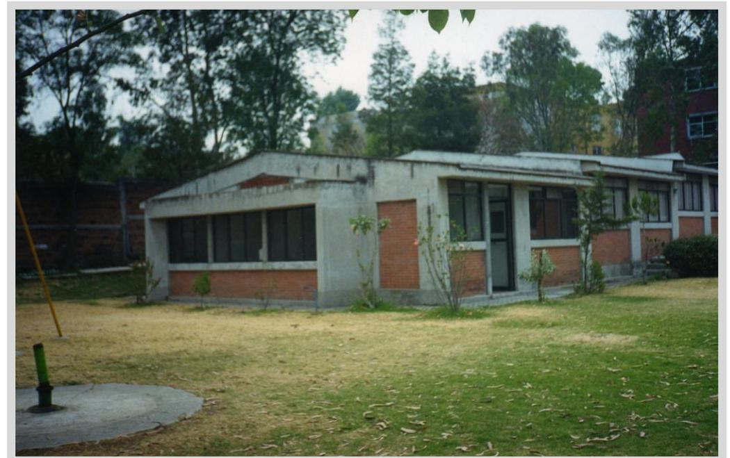
Esta es la fachada sureste del edificio, el escalonamiento de las cubiertas obedece a la pendiente del terreno, la cancelaria es a base de aluminio duranodick y cristal filtra sol de 6 mm., los muros son de tabique rojo refractario, los muretes son rematados con una plancha de concreto, el acabado de trabes y columnas de concreto es aparente, los pasillos y plazas exteriores el acabado es con adoquín de 8 cms., color terracota.
