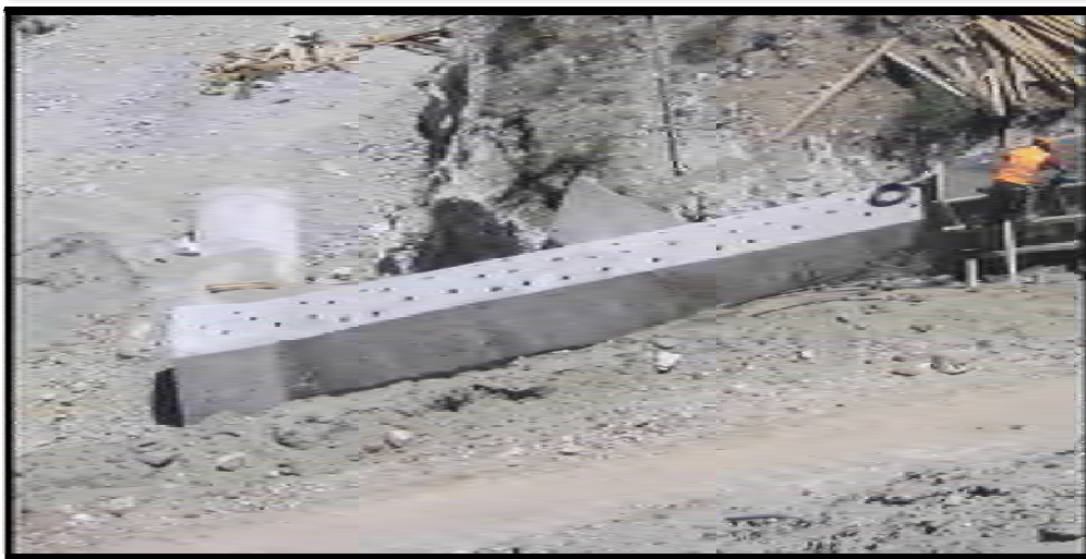
FIGURA 3.11. Sistema decantador drenante existente (imágenes proporcionadas por el departamento de Planeación de Minería La Negra)
