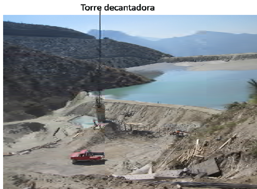
FIGURA 2.12. Sistema decantador drenante
