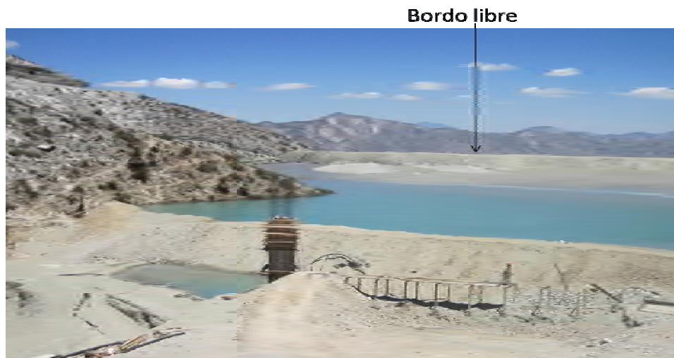
FIGURA 2.10. Cortina contenedora (arriba) y bordo libre (abajo), depósito para jales minera La Negra
