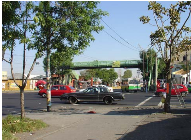
Vista del Puente Peatonal desde la acera contraria; del lado superior izquierdo se aprecia parte de la barda que contiene el predio en color naranja.
