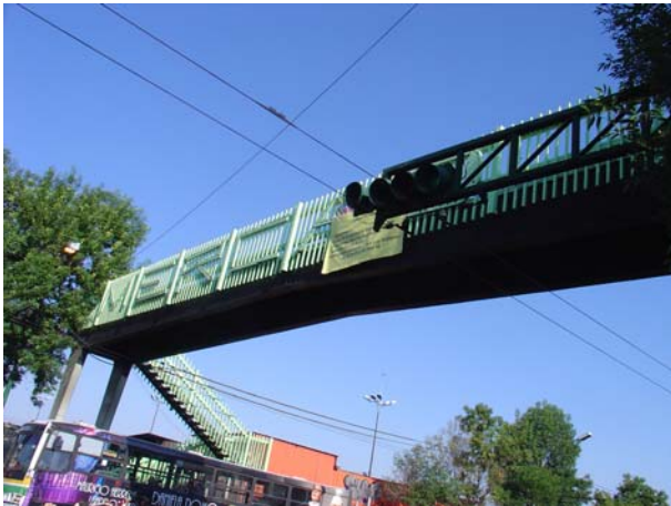
Acercamiento Puente Peatonal
