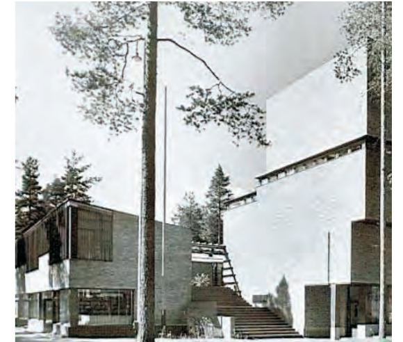
VOLUMETRÍA ORTOGONAL Y DE ALTURAS VARIABLES, RESALTA LA ESCALINATA DE ACCESO ENTRE AMBAS MASAS.
