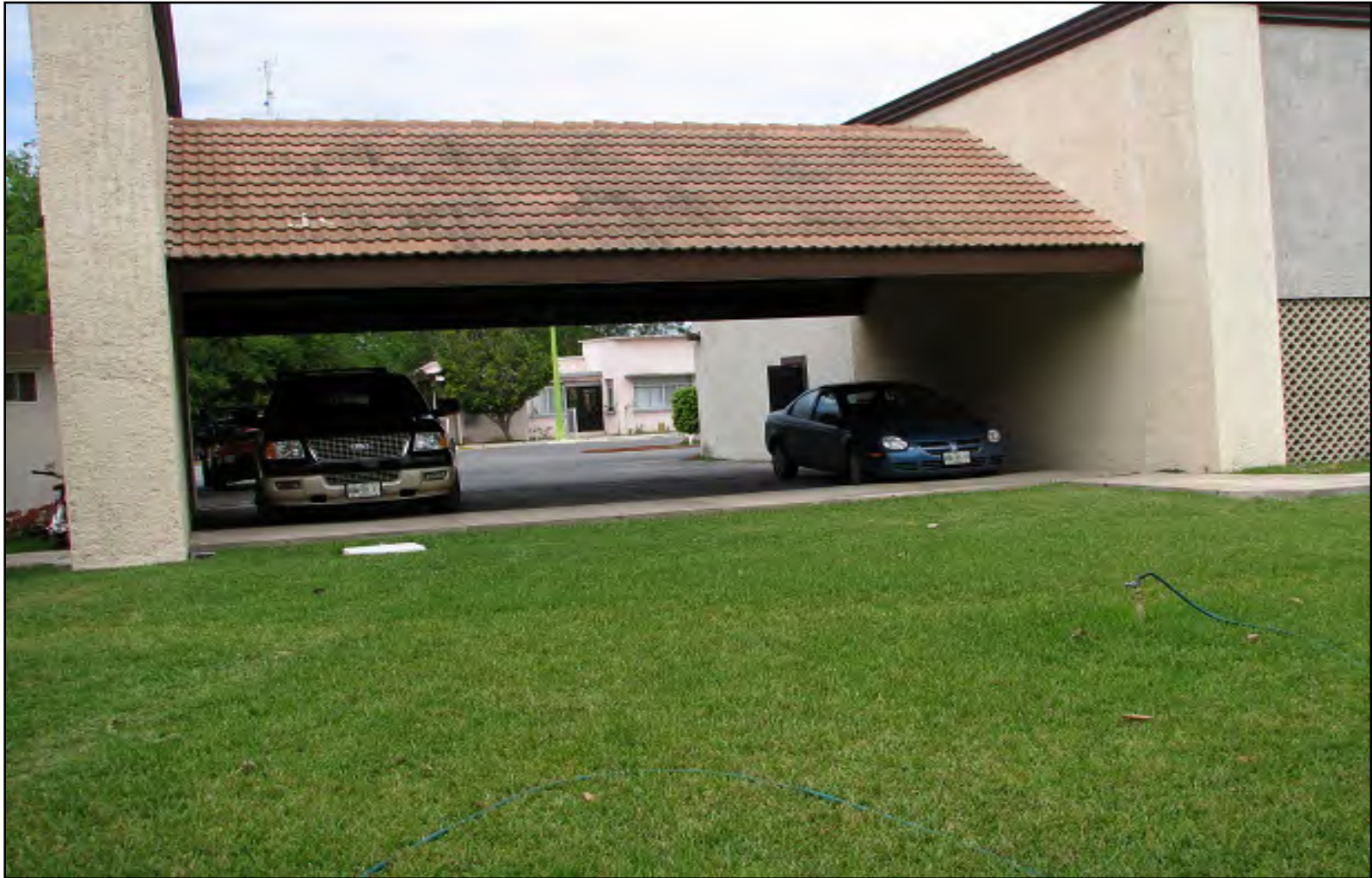
Estacionamiento techado Casa de Visitas Reynosa
