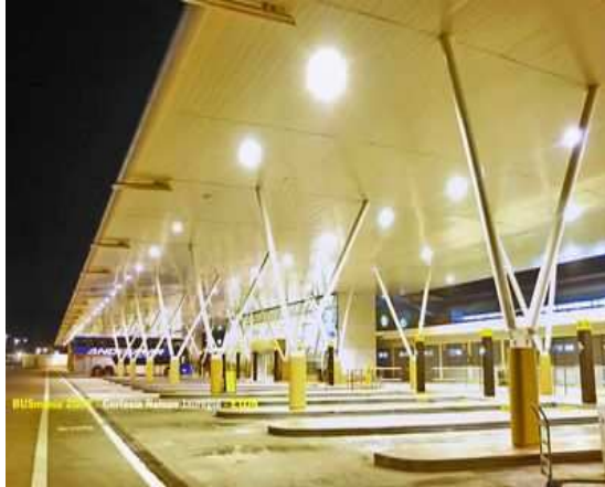
Gráfico 23. Especial atención en el diseño de circulaciones para autobuses y área de andenes.
