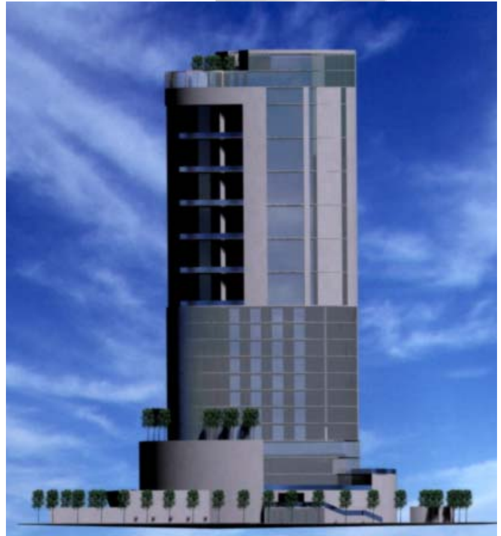
Fachada Norte, hacia la calle Yucatán
