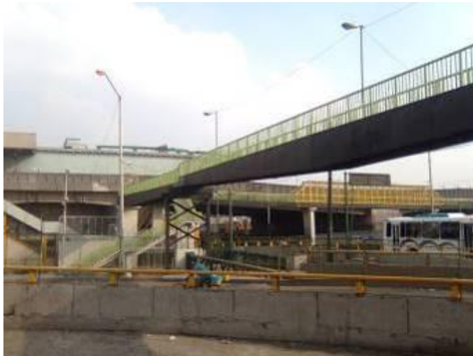
Estación del metro Pantitlan
