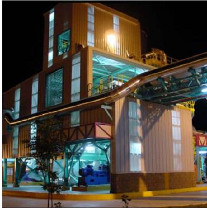
**Figura 11.** Unidad WSA ya instalada en la refinería Agip Petroli en Gela, Italia.
