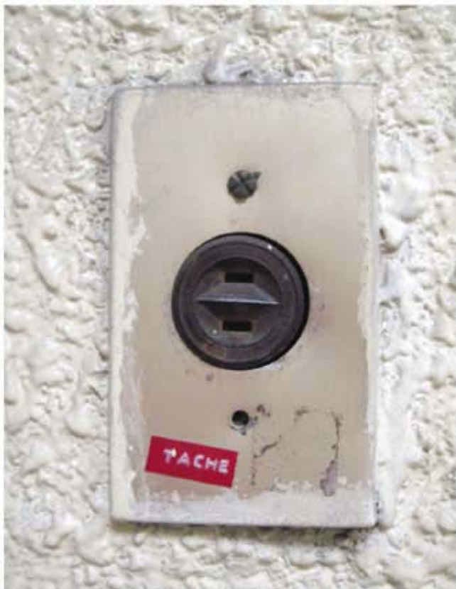
Foto 308. Tache. Metro de la Ciudad de México.
