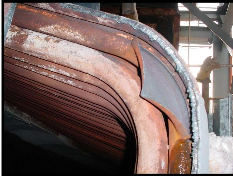
*Figura 1.6. Corrosión por esfuerzo (stress) en una caldera con presión alta<sup>14</sup>.*
