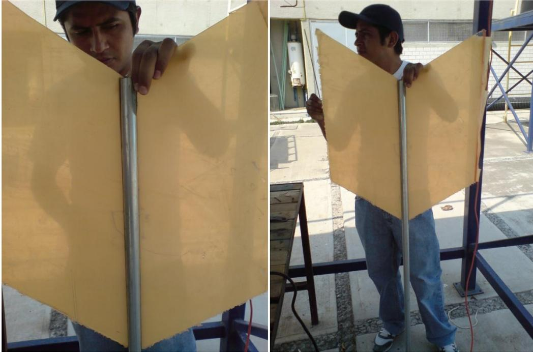
Imagen 4.74 Montando el acrílico en el espacio generado del tubo Conduit.
