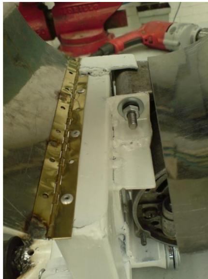
Imagen 4.81 Remachando la lamina a la base del mini aerogenerador.
