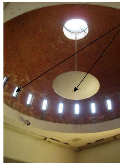
La iluminación se resuelve de la misma manera que los otros talleres por medio de vanos en la cúpula de la cubierta y luminarias colgantes de luz indirecta
