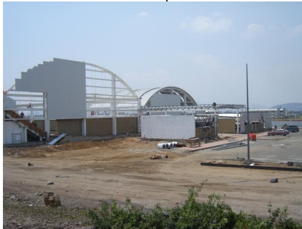
Foto No. 7 Construcción del gimnasio techado de la Unidad Deportiva.
