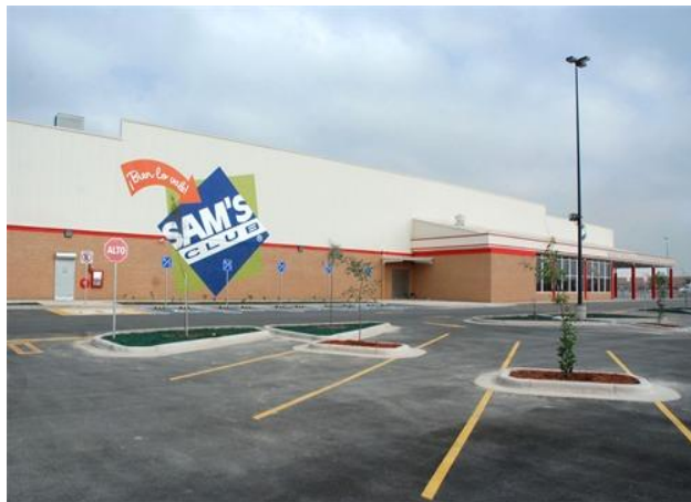
Foto No. 9 La obra terminada.
