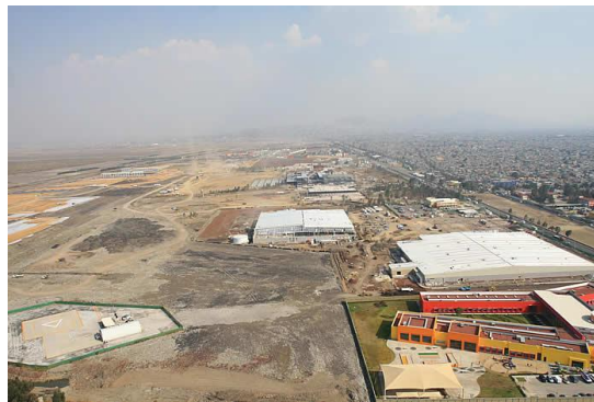
Foto No. 5 Construcción de la Unidad Comercial
